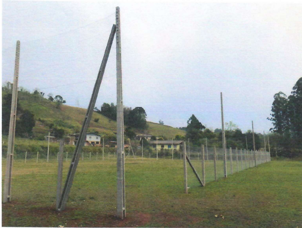
Foto 09 – dia 04/09/2024 – Alambrado do campo da Linha Gaúcha executado.
