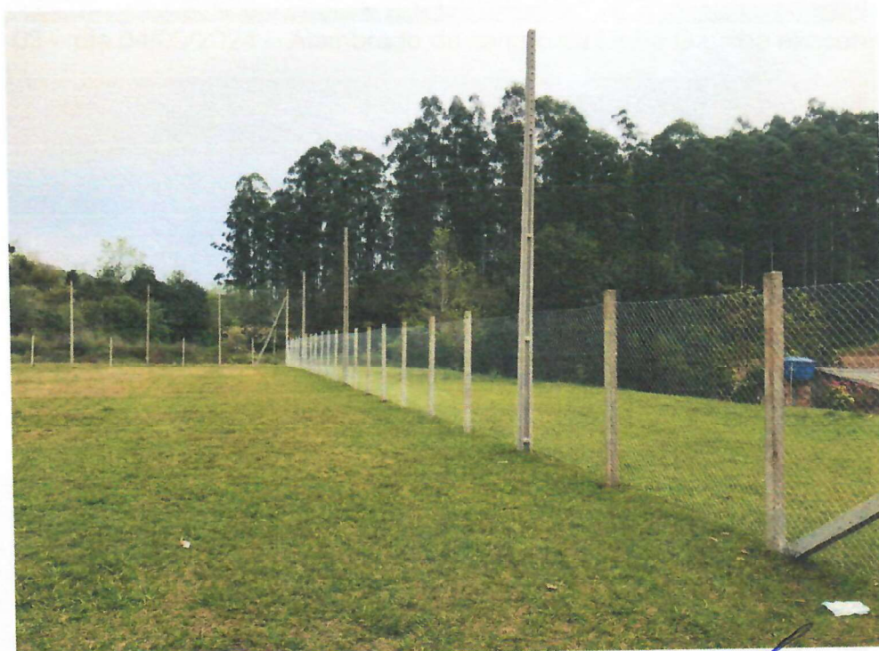
Foto 02 – dia 04/09/2024 – Alambrado do campo da Linha Gaúcha executado.
