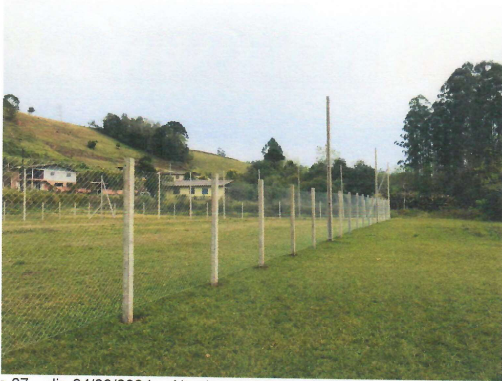
Foto 07 – dia 04/09/2024 – Alambrado do campo da Linha Gaúcha executado.
