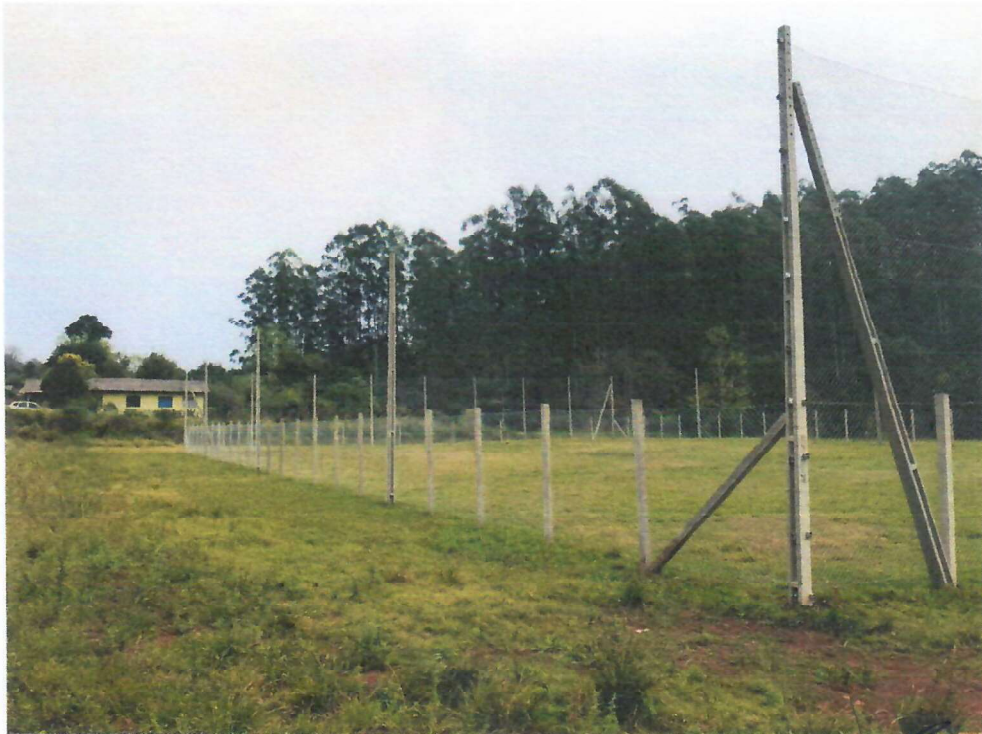
Foto 12 – dia 04/09/2024 – Alambrado do campo da Linha Gaúcha executado.
