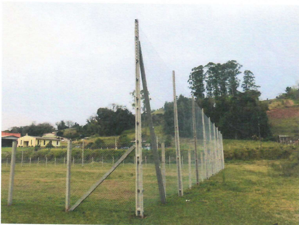
Foto 08 – dia 04/09/2024 – Alambrado do campo da Linha Gaúcha executado.
