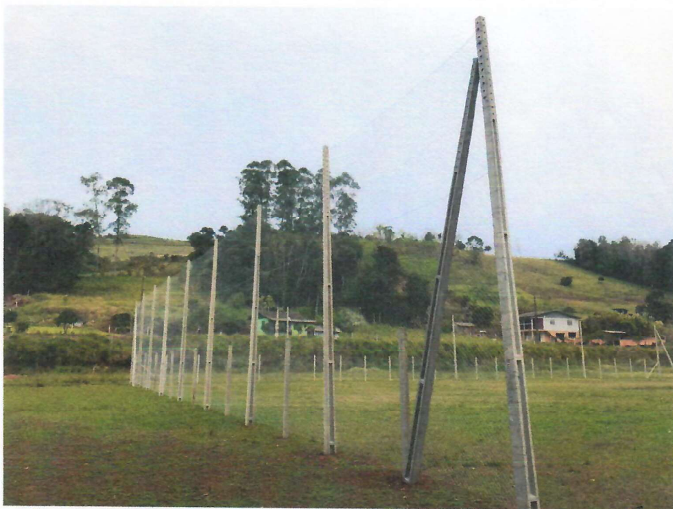
Foto 10 – dia 04/09/2024 – Alambrado do campo da Linha Gaúcha executado.
