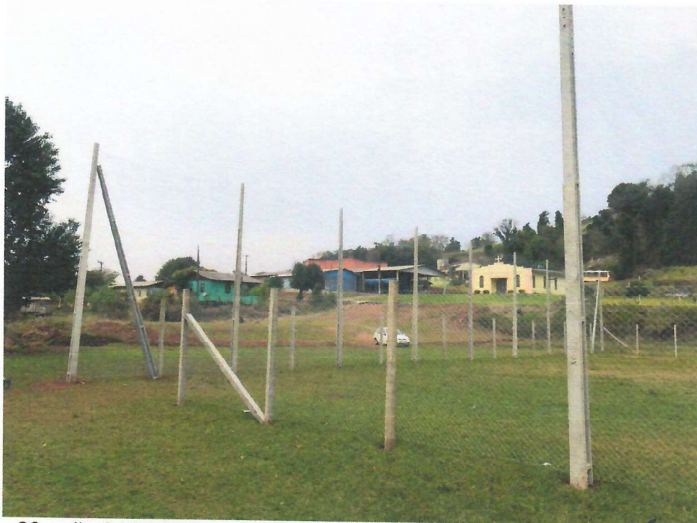
Foto 06 – dia 04/09/2024 – Alambrado do campo da Linha Gaúcha executado.
