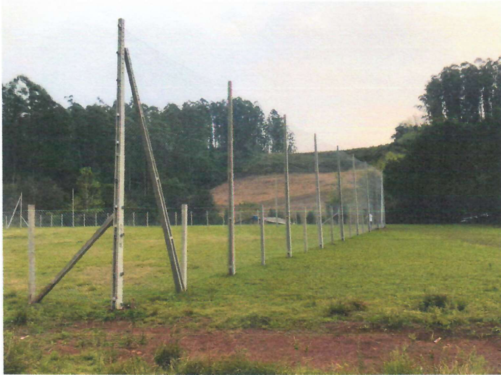
Foto 11 – dia 04/09/2024 – Alambrado do campo da Linha Gaúcha executado.
