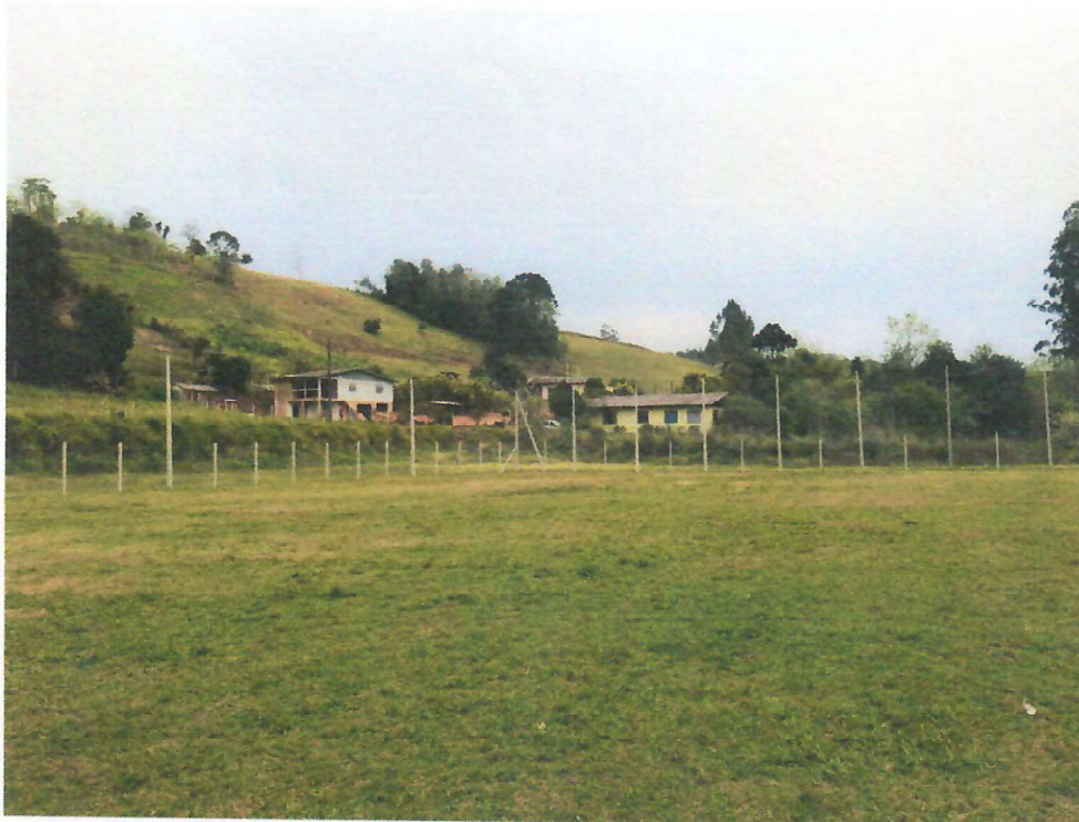
Foto 03 – dia 04/09/2024 – Alambrado do campo da Linha Gaúcha executado.
