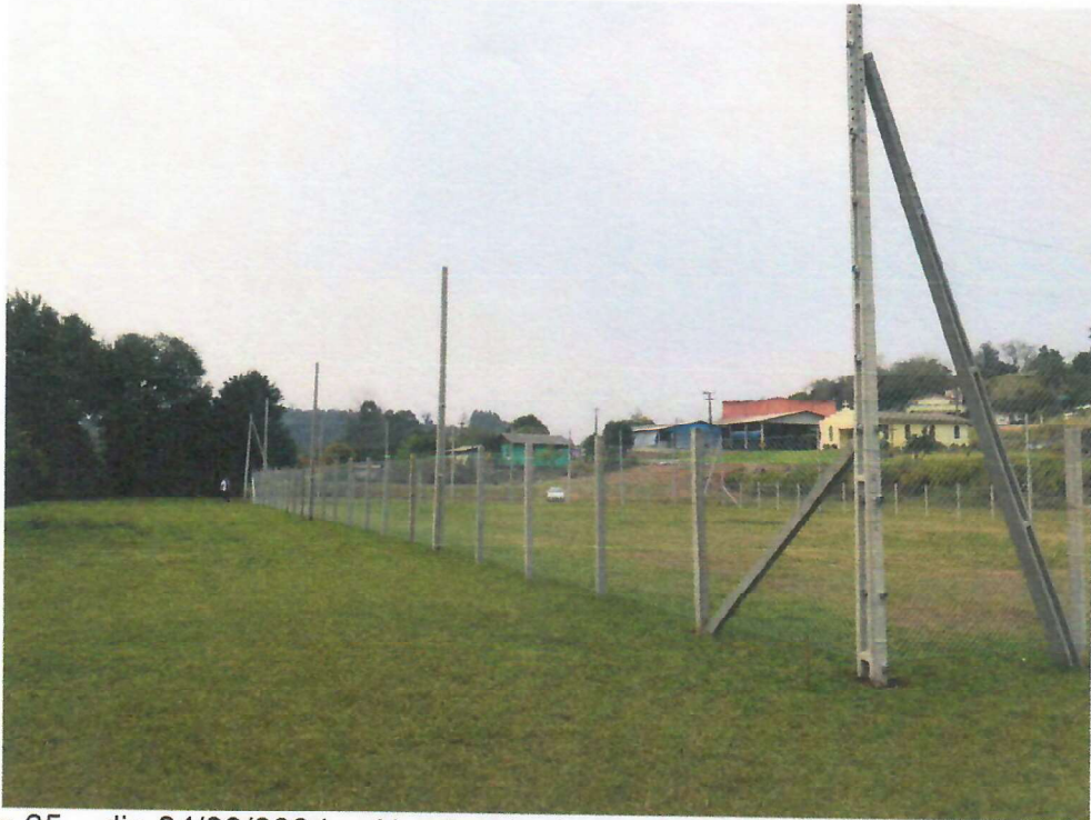
Foto 05 – dia 04/09/2024 – Alambrado do campo da Linha Gaúcha executado.
