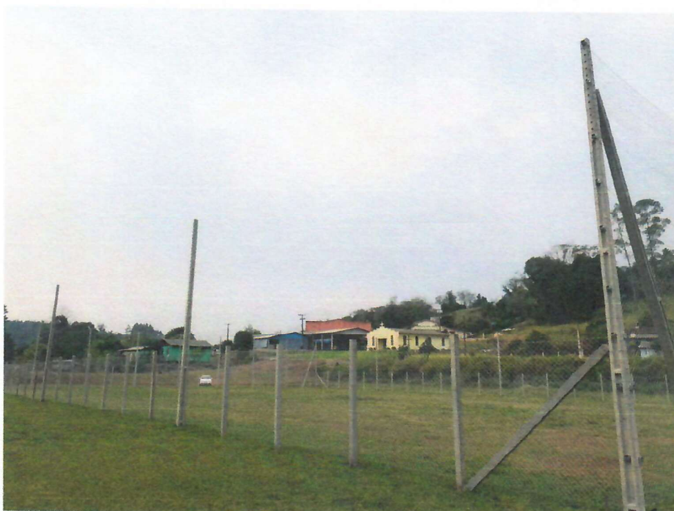
Foto 04 – dia 04/09/2024 – Alambrado do campo da Linha Gaúcha executado.
