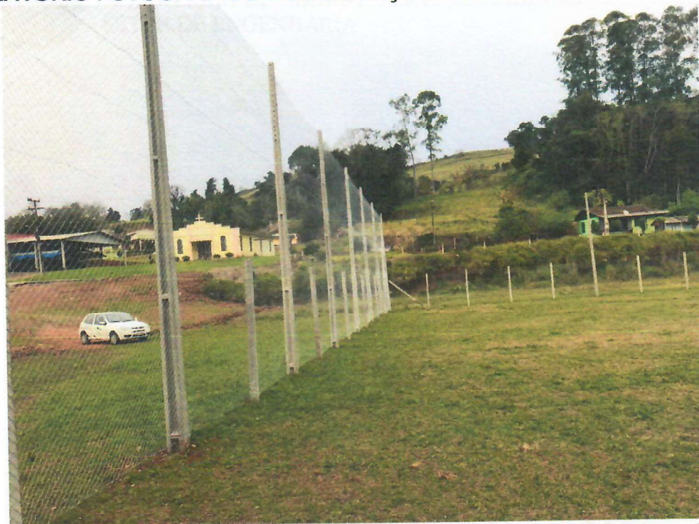
Foto 01 – dia 04/09/2024 – Alambrado do campo da Linha Gaúcha executado.
