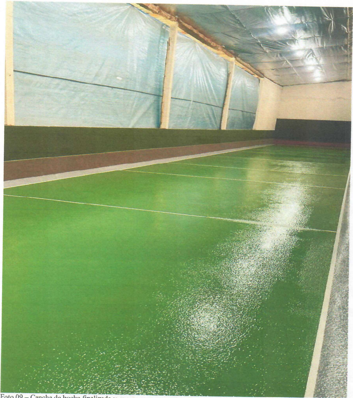
Foto 09 – Cancha de bocha finalizada
