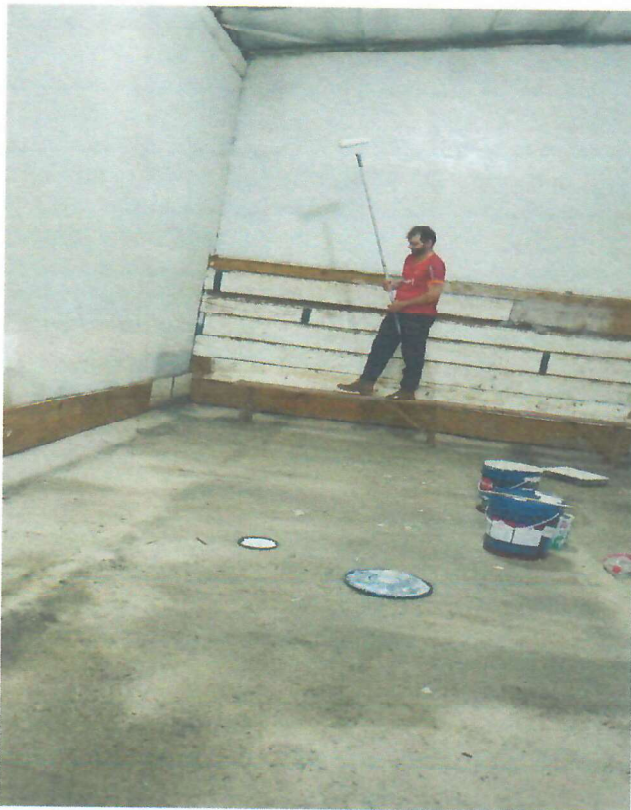
Foto 02 – Cancha de Bocha, piso bruto
