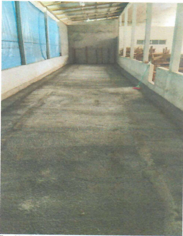
Foto 01 – Cancha de Bocha, piso bruto
