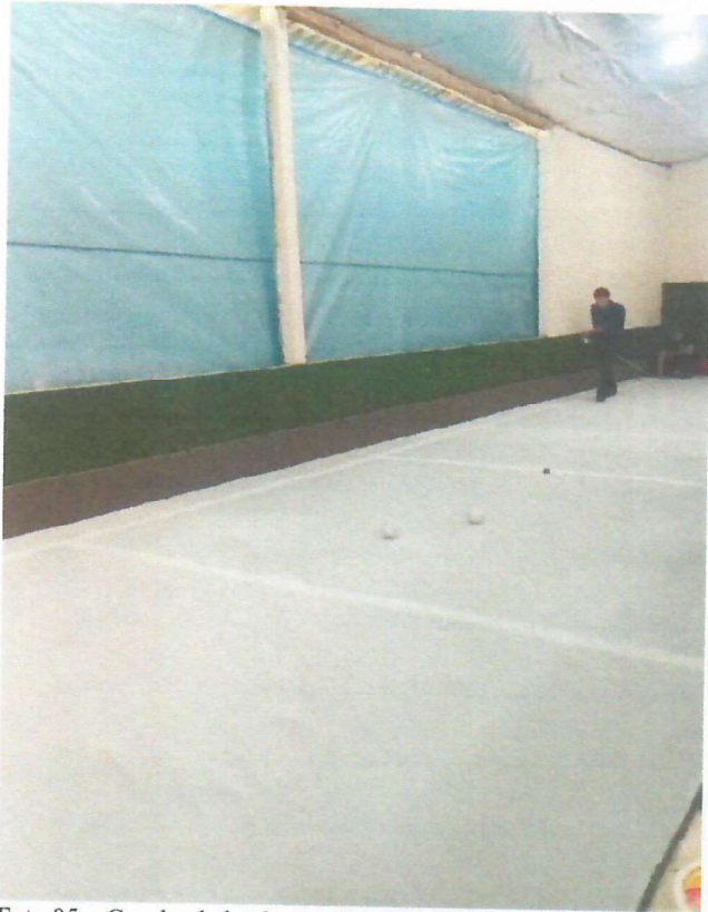
Foto 05 – Cancha de bocha sendo executada
