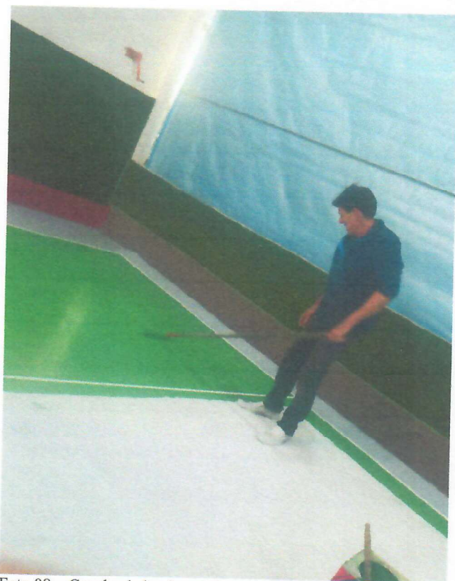
Foto 08 – Cancha de bocha sendo executada
