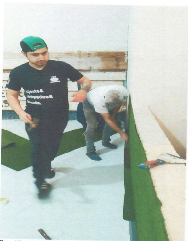
Foto 07 – Cancha de bocha sendo executada
