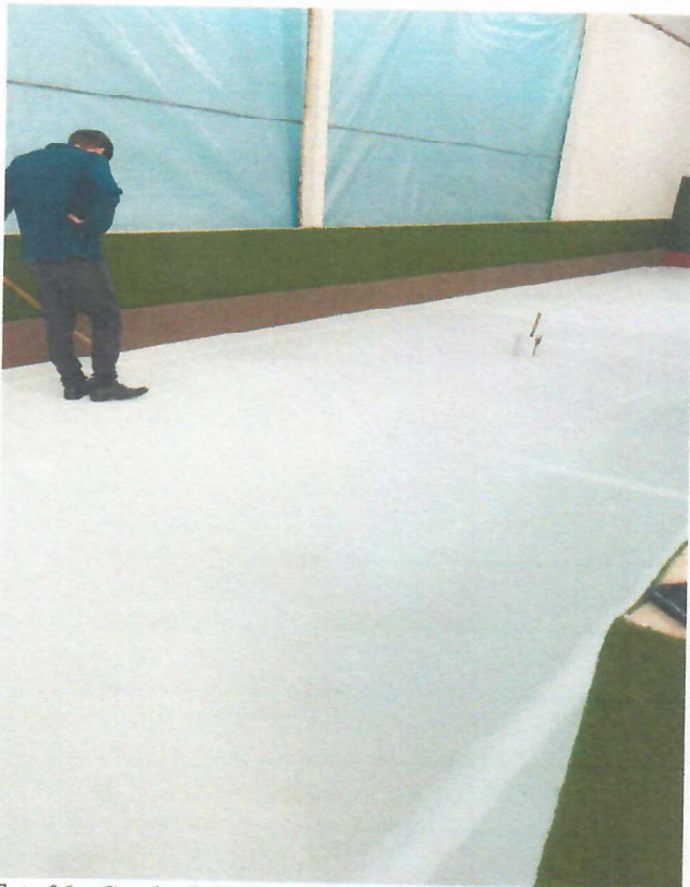
Foto 06 – Cancha de bocha sendo executada
