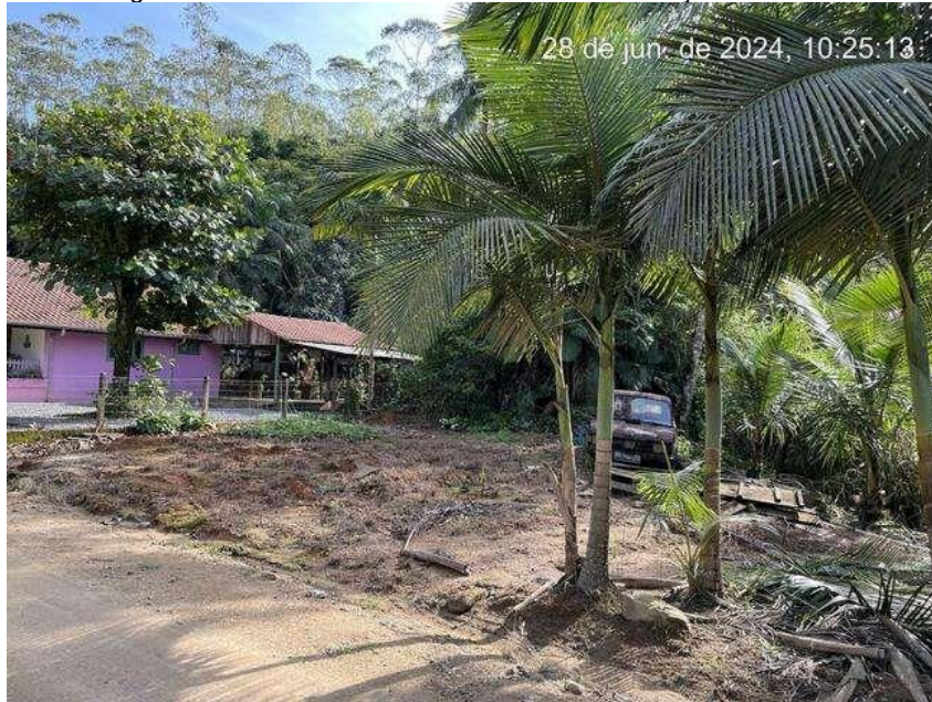
Imagem 05 – Vista da área onde foi demolida edificação em madeira
