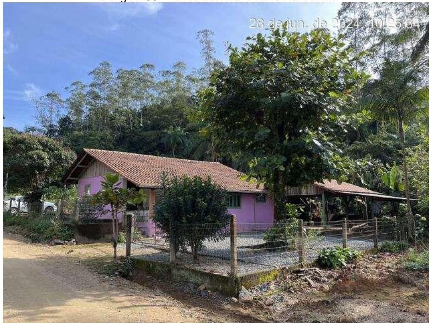
Imagem 06 – Vista da residência em alvenaria
