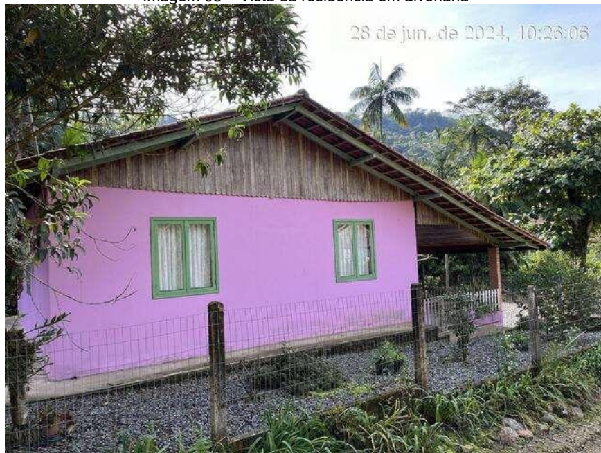
Imagem 08 – Vista da residência em alvenaria
