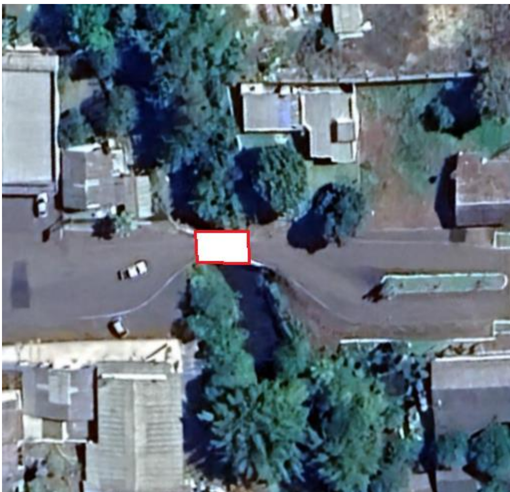
FIGURA 02 - Localização da Ponte (imagem google) - Coordenadas -26°43'49'' S - 52°43'02'' O
