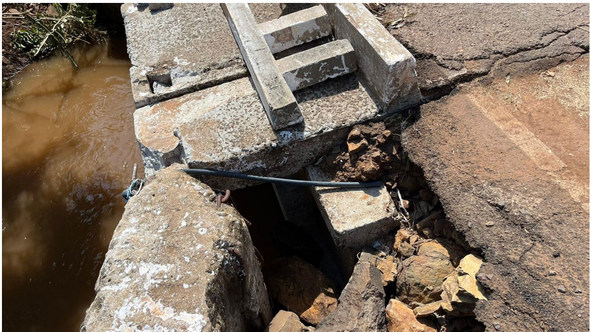
Vista Movimentação Cabeceira
