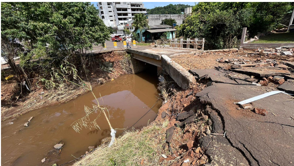
Vista Ponte a Jusante
