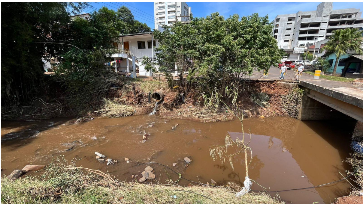
Vista Rio a Jusante
