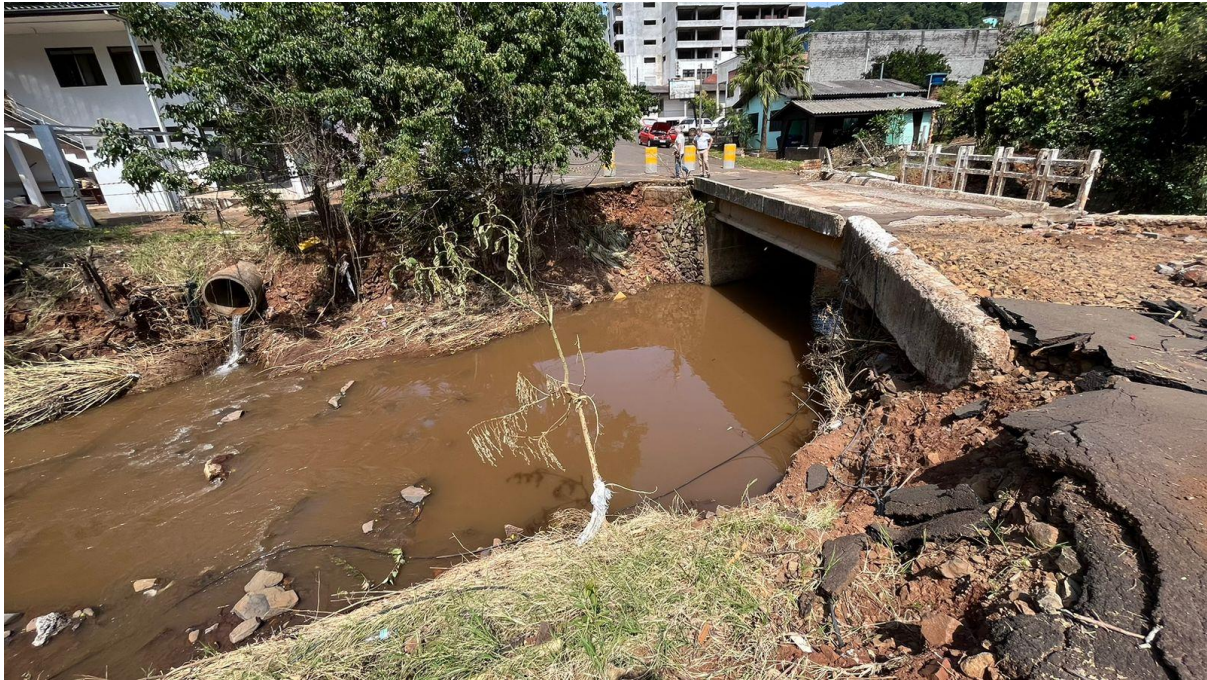
Vista Rio a Jusante
