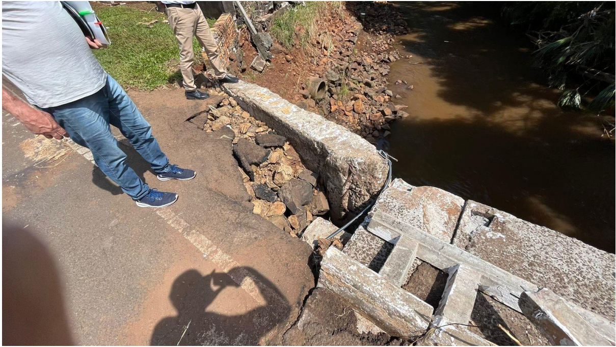
Vista Movimentação Cabeceira
