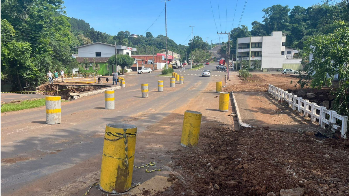
Vista Geral da Ponte (sentido fluxo sul- norte)
