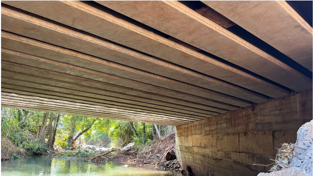
Vista Geral Vigas Transversinas - Intactas
