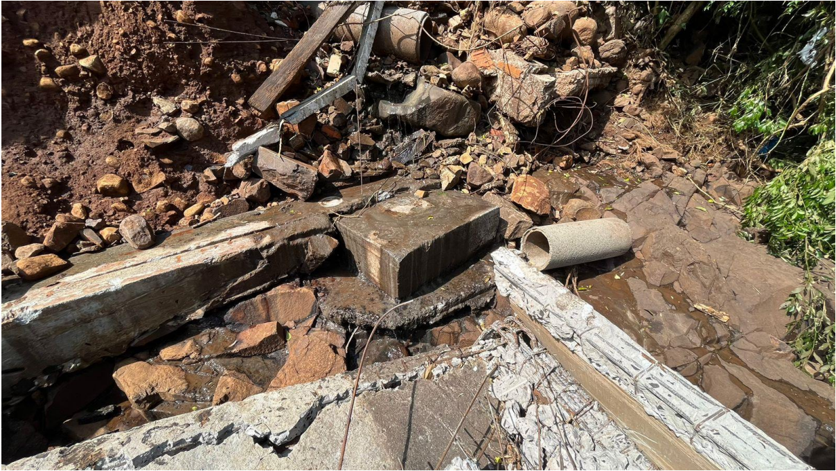
Vista Fundações Cabeceira (lado sul)
