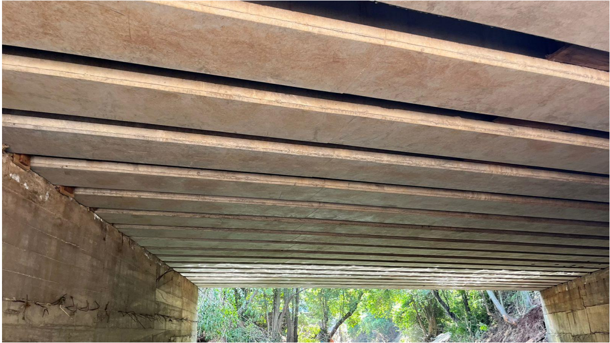
Vista Geral Vigas Transversinas
