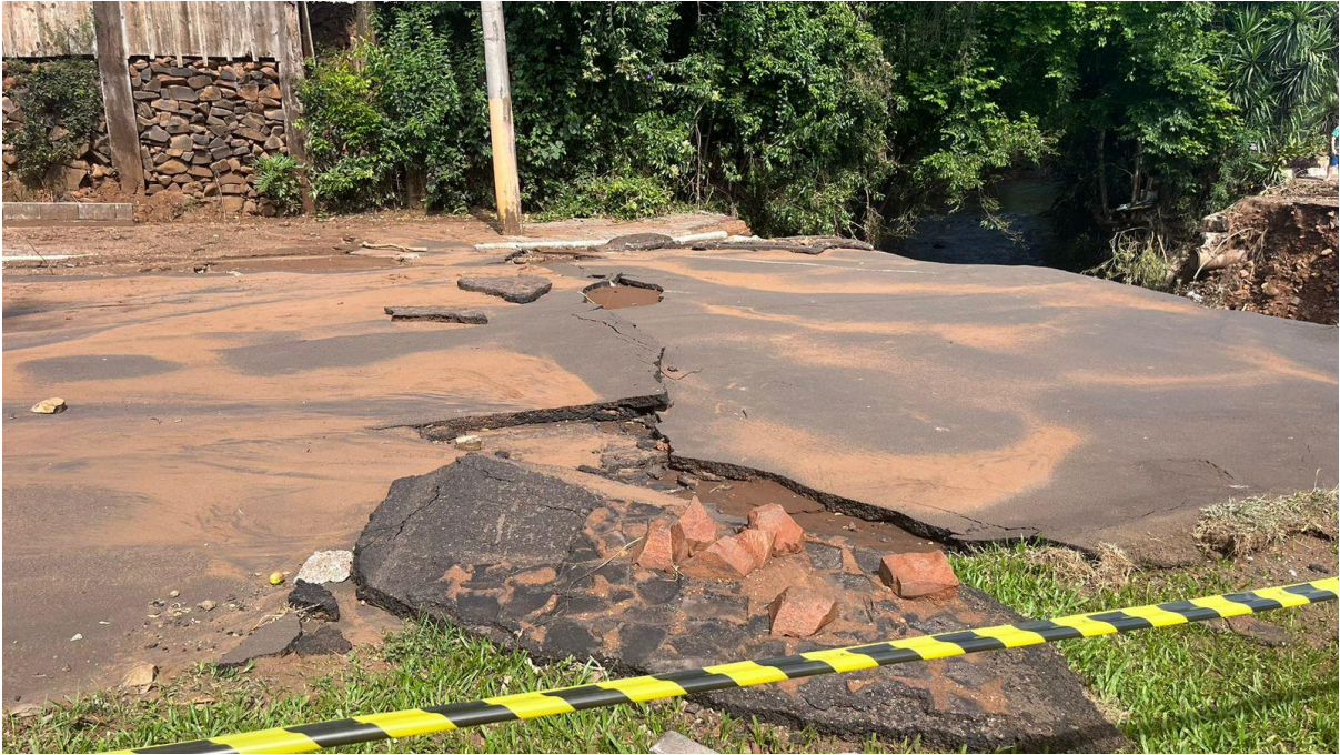
Vista Parcial da Ponte
