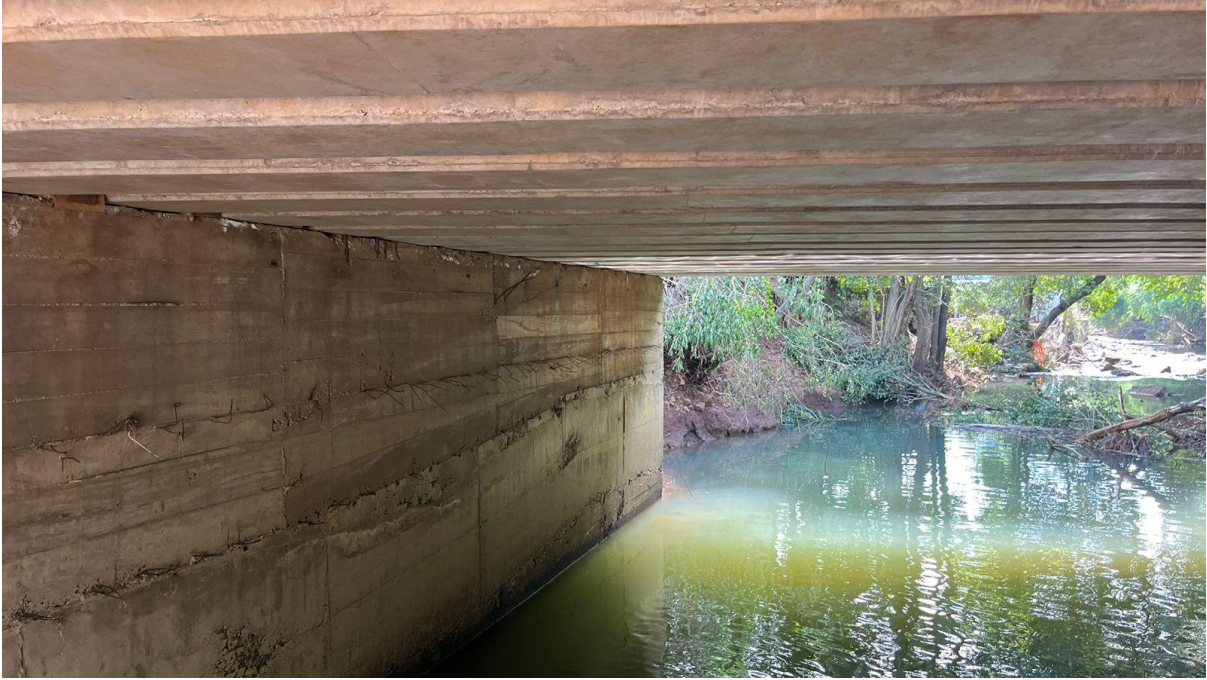
Vista Longarinas de Cabeceira Lado norte - Intactos
