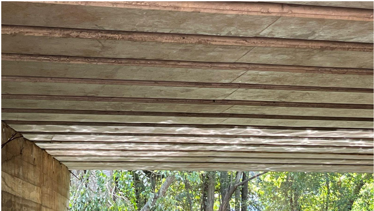
Vista Geral Vigas Transversinas
