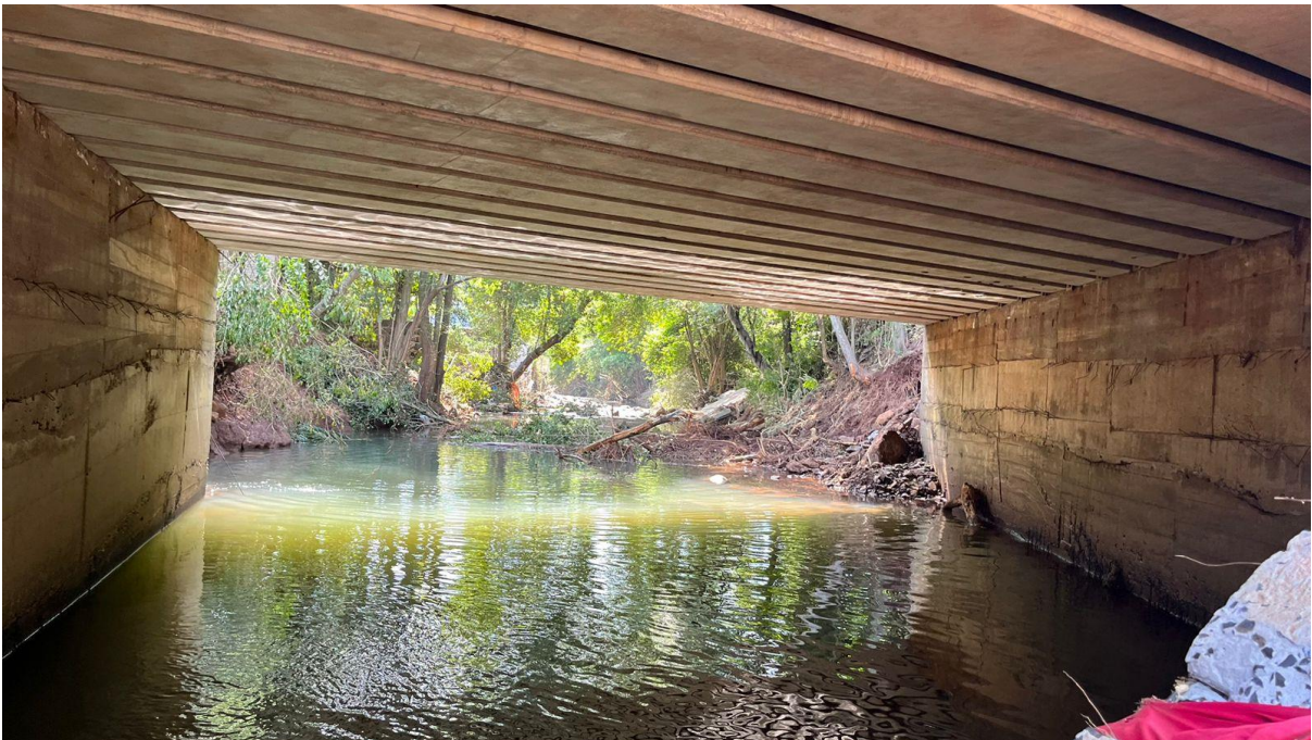
Vista geral das estruturas da ponte centro norte - encontra-se intacta apta para uso
