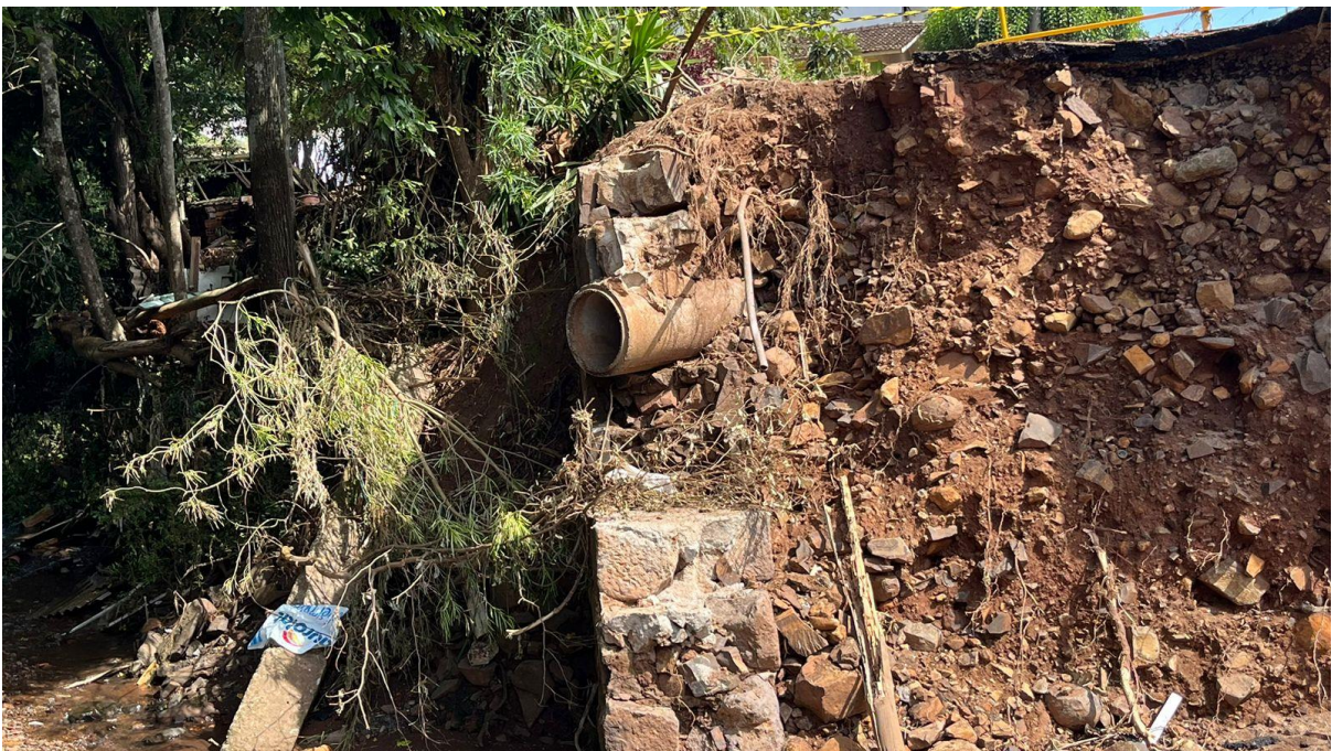
Vista de Rede de Águas Pluviais (Lado norte)
