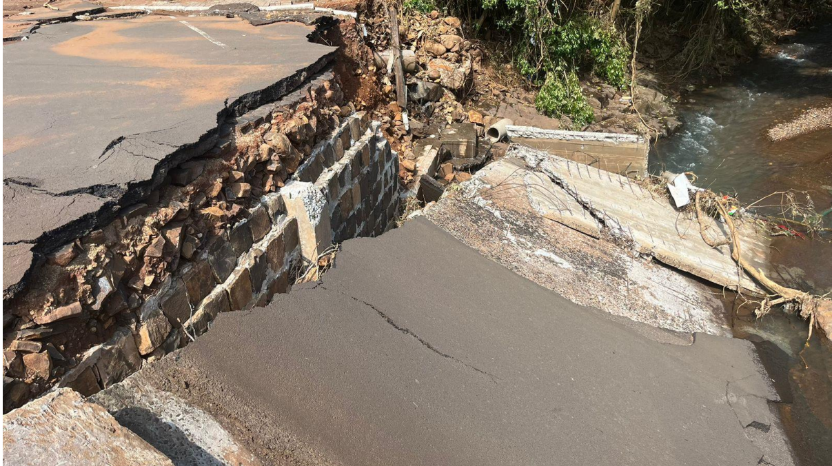
Vista Cabeceira (lado sul)
