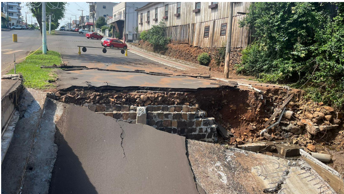
Vista Cabeceira (lado sul)
