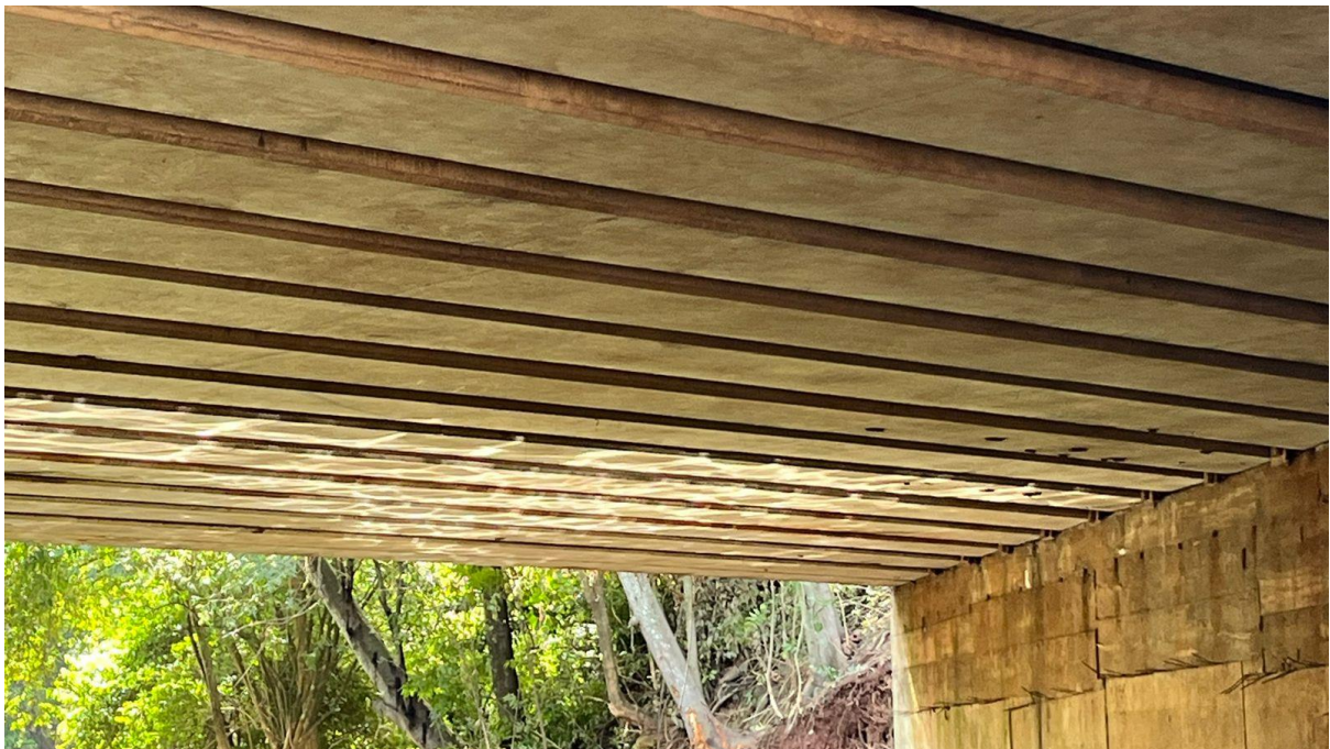
Vista Geral Vigas Transversinas - Intactas
