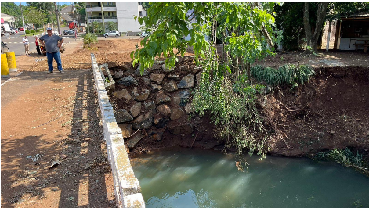
Vista Passeio e enrocamento de pedras a Jusante
