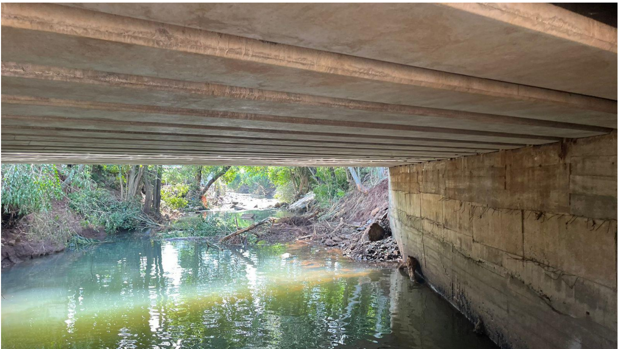
Vista Longarinas de Cabeceira lado sul - Intactos
