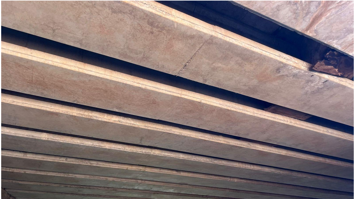
Vista Geral Vigas Transversinas - Intactas
