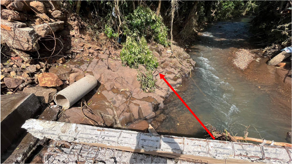
Vista Rocha a montante da ponte (remover)
