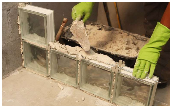
Fig. Exemplo de execução de alvenaria com tijolo de vidro.
