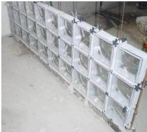
Fig. Exemplo de execução de alvenaria com tijolo de vidro.
