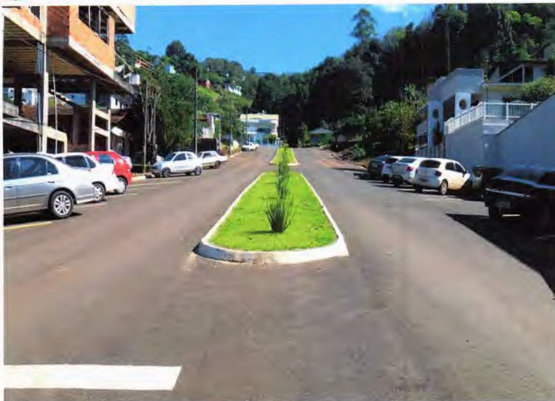
Figura 11 – META 03 – Pavimentação da Rua Marechal Deodoro – Concluída
