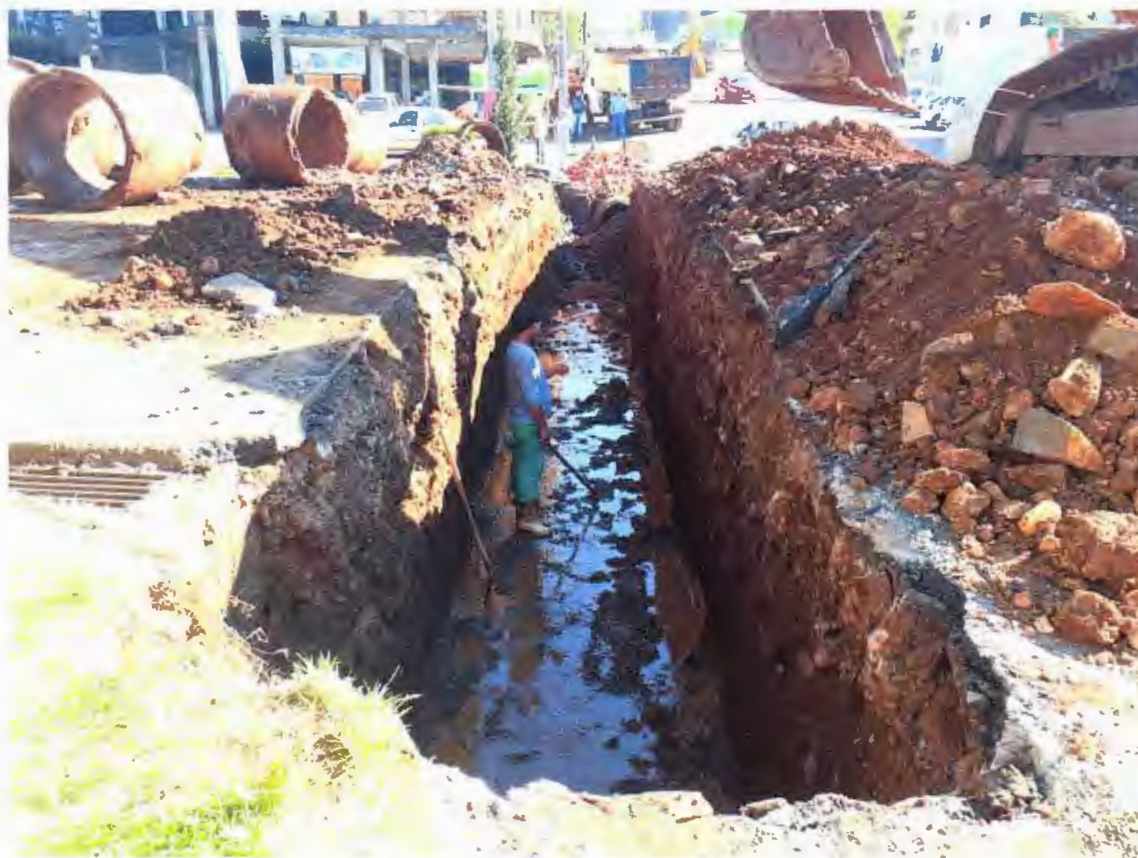
Figura 08 – META 02 - Execução do sistema de drenagem na Rua Marechal Deodoro
