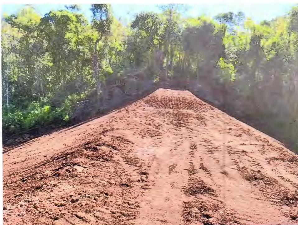
Foto 16 – Dia 15/04/2020, barramento à montante
