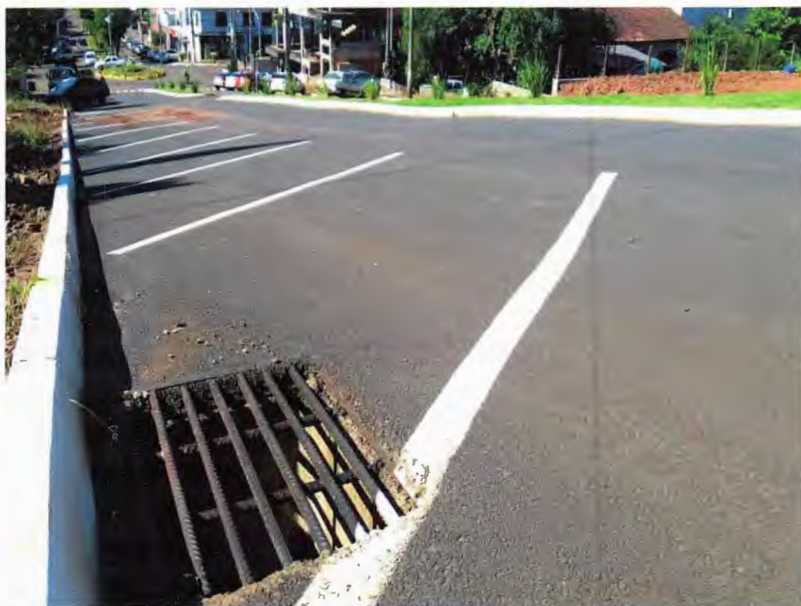
Figura 10 – META 02 - Execução do sistema de drenagem na Rua Marechal Deodoro – Concluída
