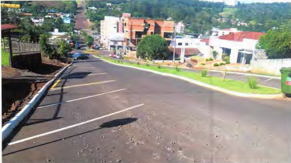
Figura 13 – META 03 – Pavimentação da Rua Marechal Deodoro - Concluída
