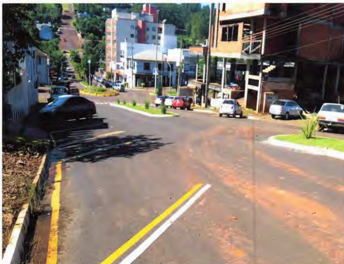
Figura 12 – META 03 – Pavimentação da Rua Marechal Deodoro - Concluída
