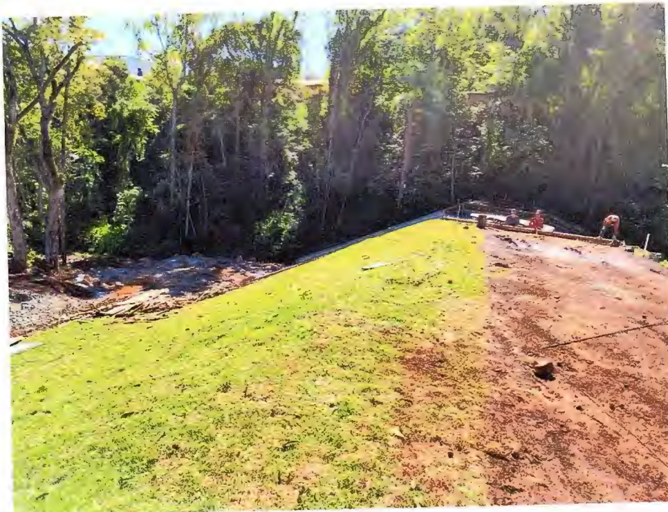
Foto 23 – Dia 15/04/2020, barramento intermediário
