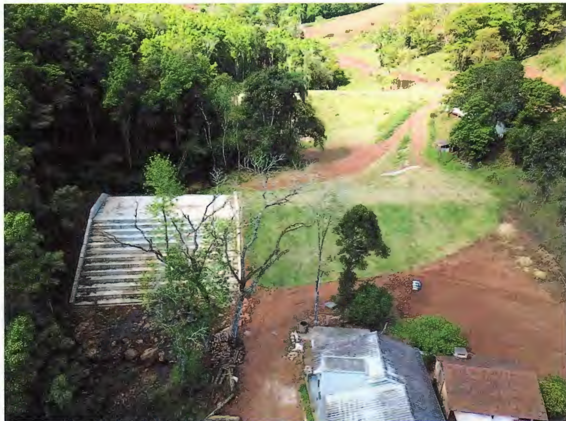
Foto 32 – Dia 22/09/2020, Aérea Barragem Concluída
