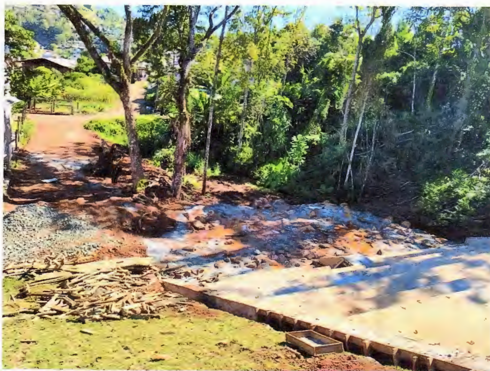
Foto 26 – Dia 15/04/2020, barramento intermediário
