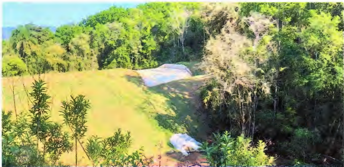
Foto 35 – Dia 22/09/2020, Barragem Concluída
