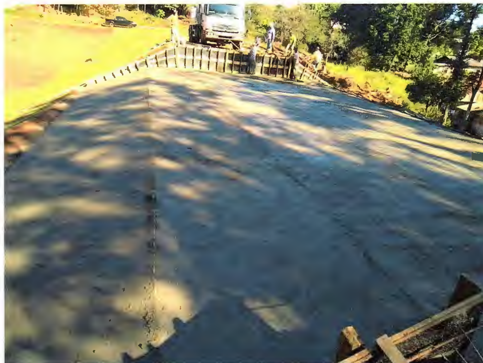
Foto 12 – Dia 13/04/2020, vertedouro concretado
