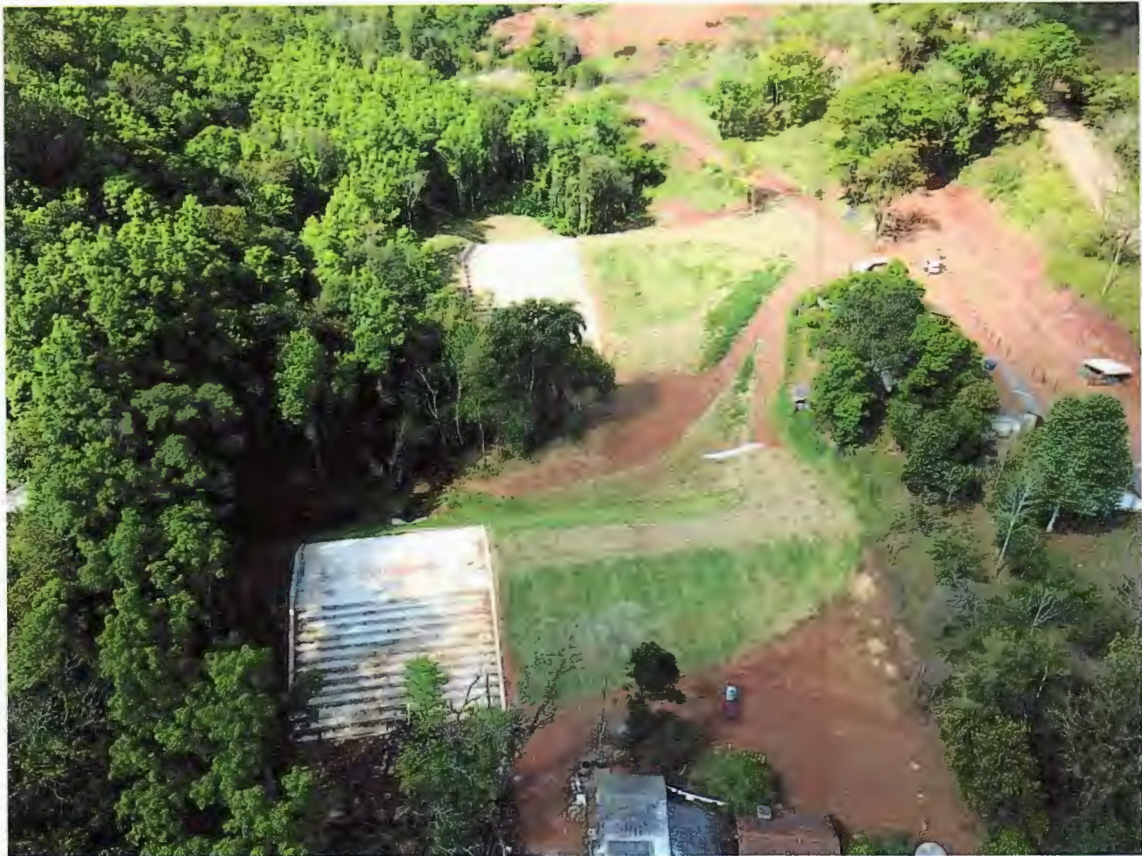
Foto 31 – Dia 22/09/2020, Aérea Barragem Concluída
