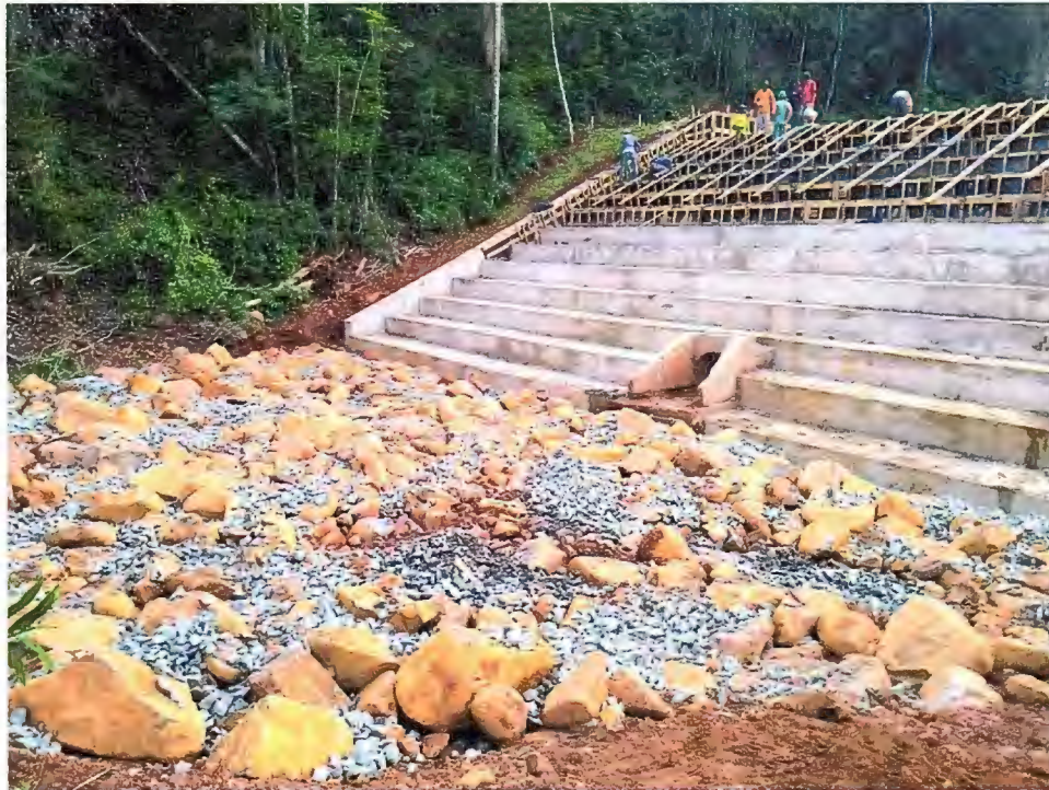
Foto 11 – Dia 02/04/2020, enrocamento e vertedouro
