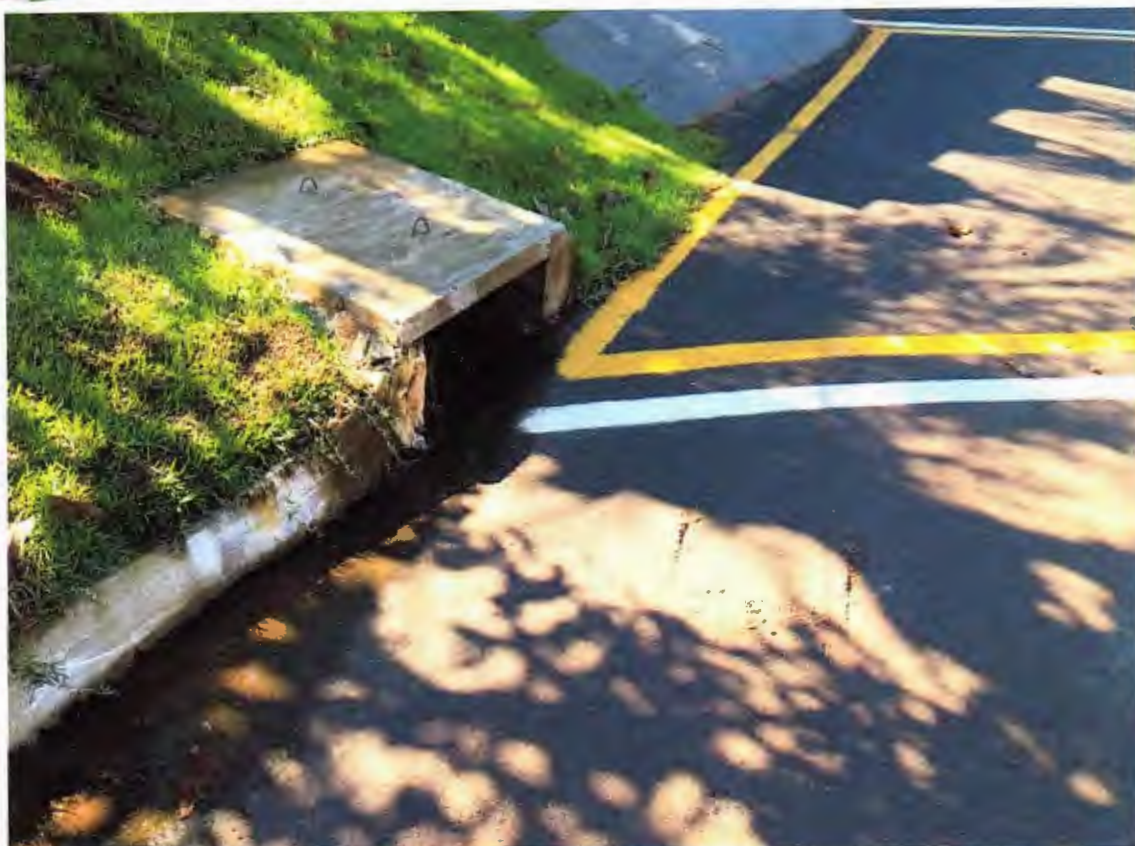
Figura 09 – META 02 - Execução do sistema de drenagem na Rua Marechal Deodoro – Concluída
