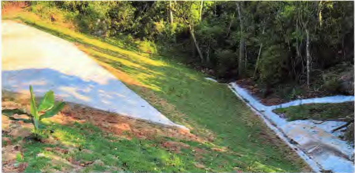
Foto 33 – Dia 22/09/2020, Barragem Concluída
