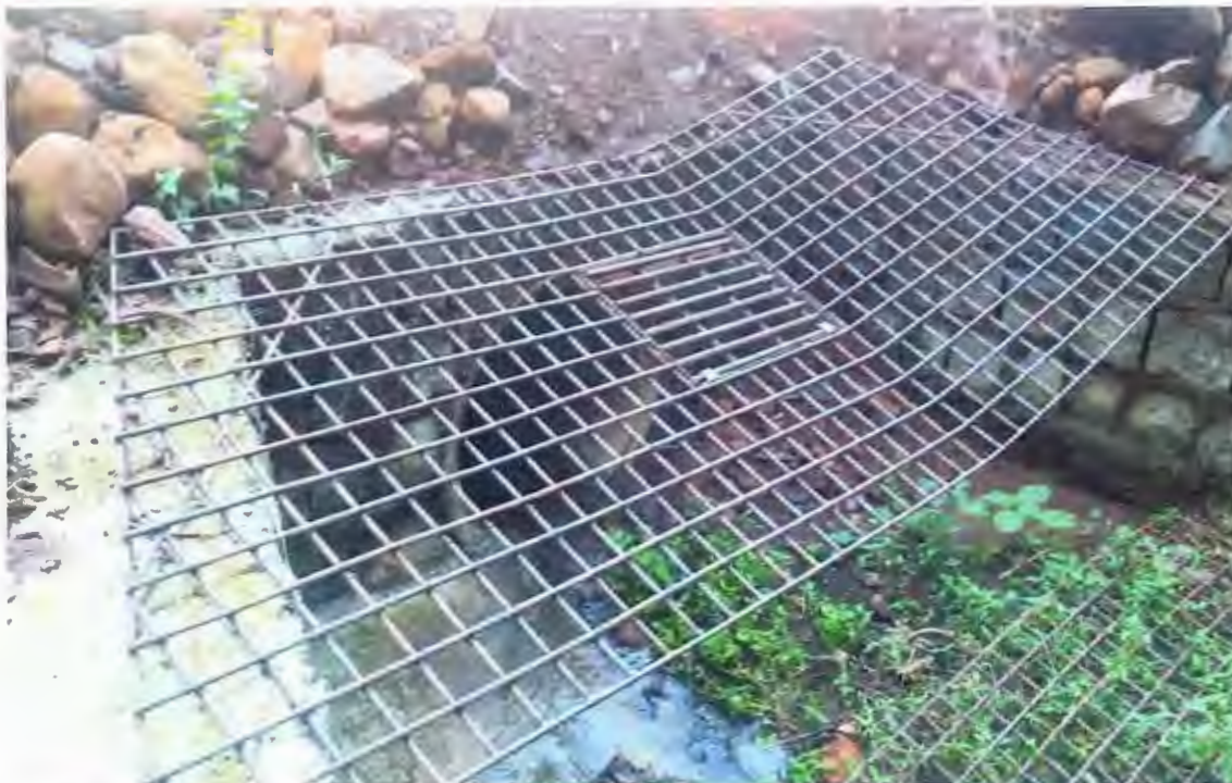
Figura 1 – META 01 - Reservatório para retenção de Água da Rua Marechal Deodoro - Concluído
