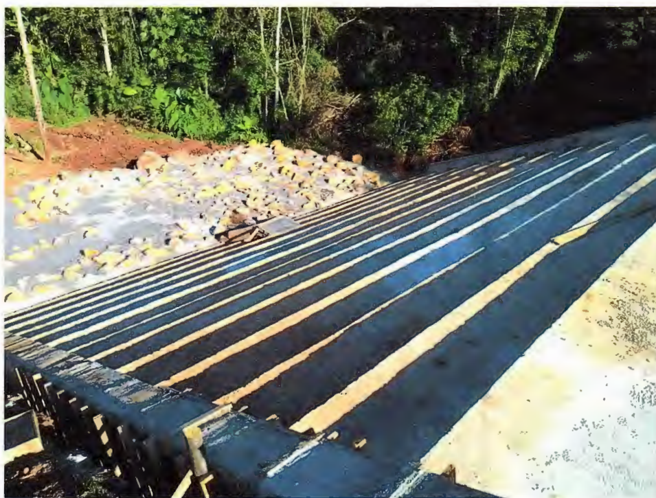
Foto 06 – Dia 07/04/2020, extravasor à jusante
