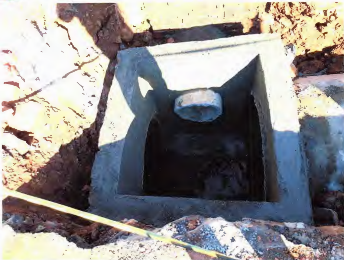
Figura 07 – META 02 - Execução do sistema de drenagem na Rua Marechal Deodoro
