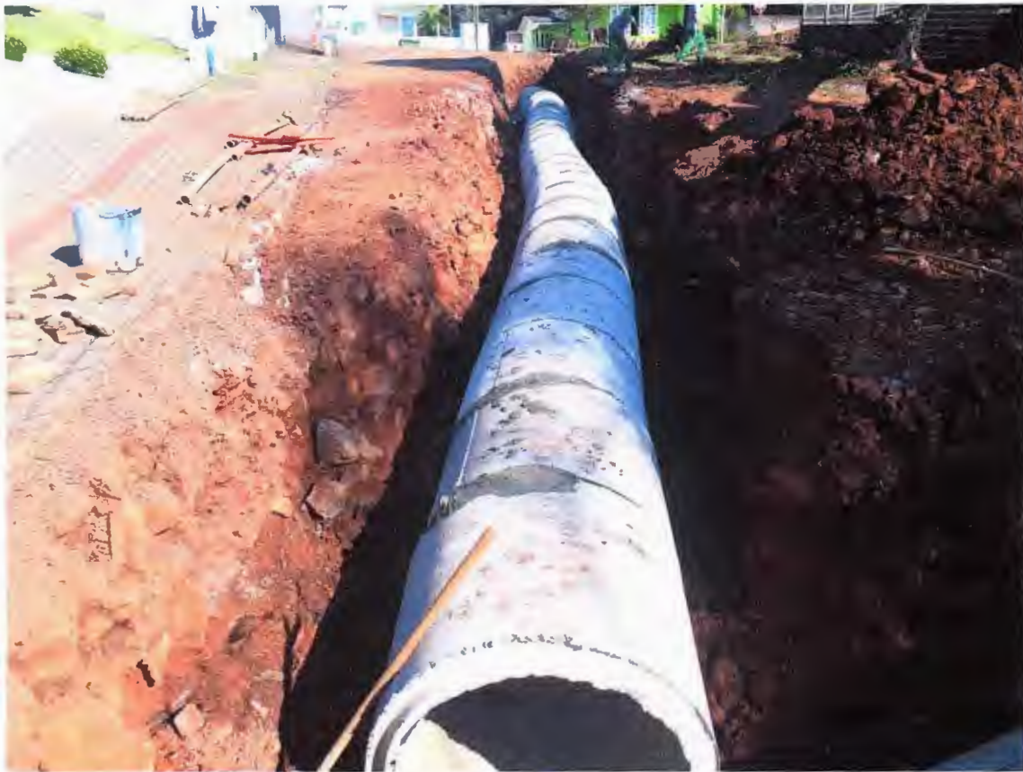
Figura 05 – META 02 - Execução do sistema de drenagem na Rua Marechal Deodoro
