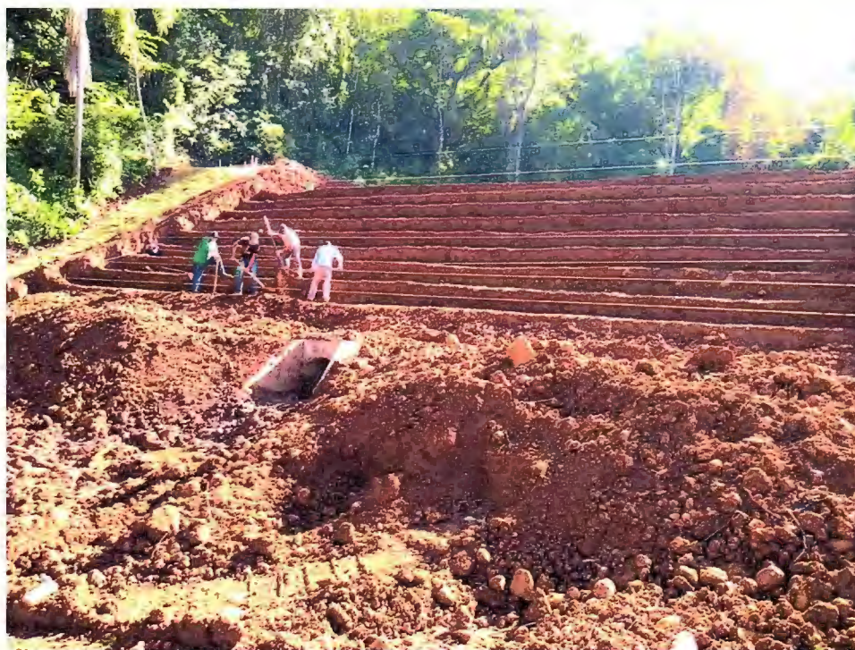
Foto 13 – Dia 15/04/2020, escavações vertedouro intermediário
