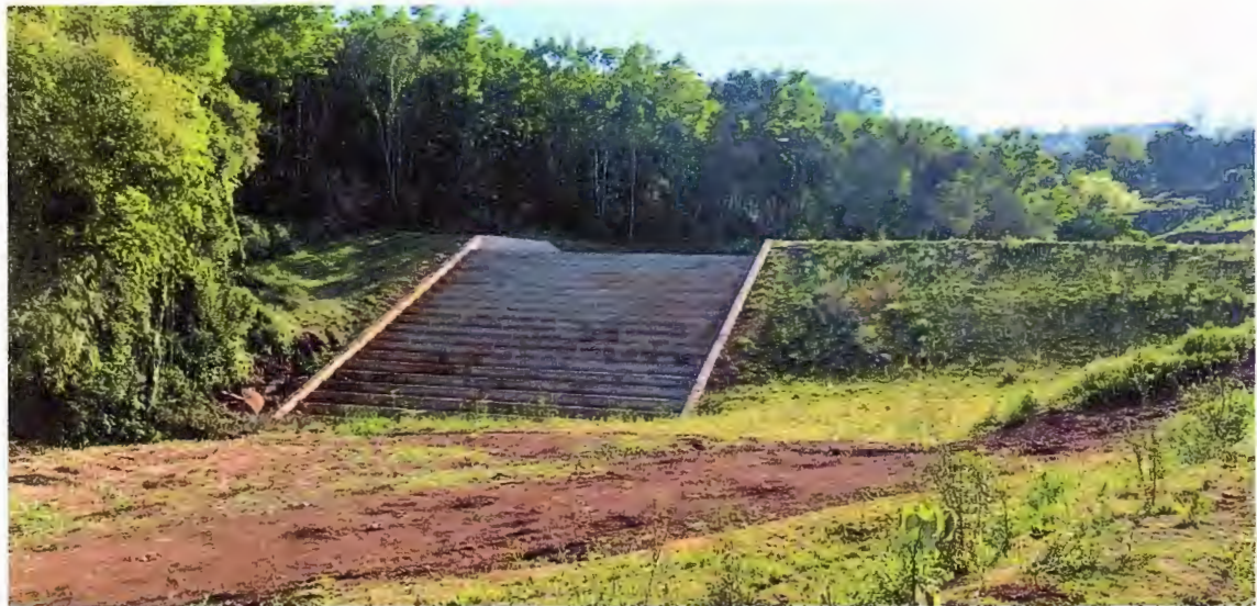
Foto 37 – Dia 22/09/2020, Barragem Concluída
