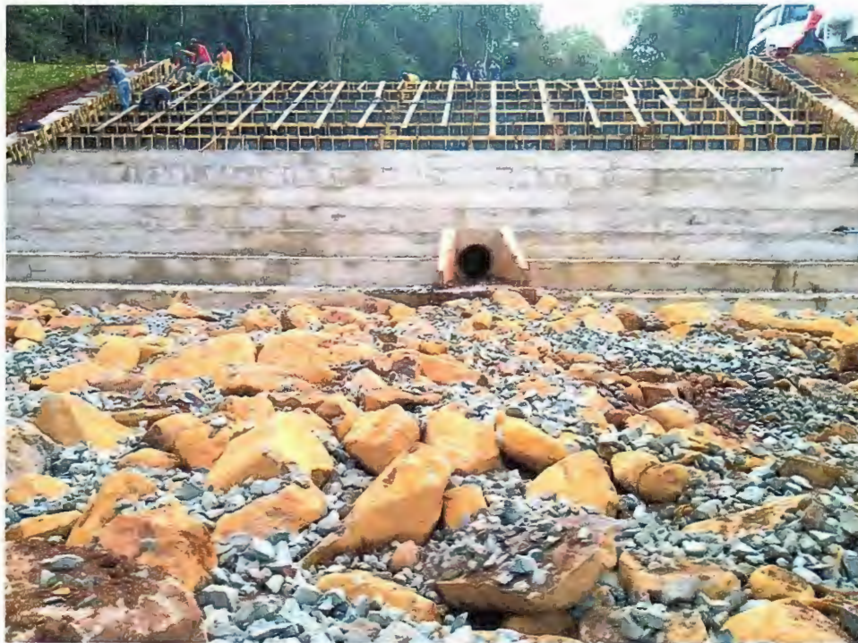
Foto 10 – Dia 02/04/2020, vertedouro à jusante
