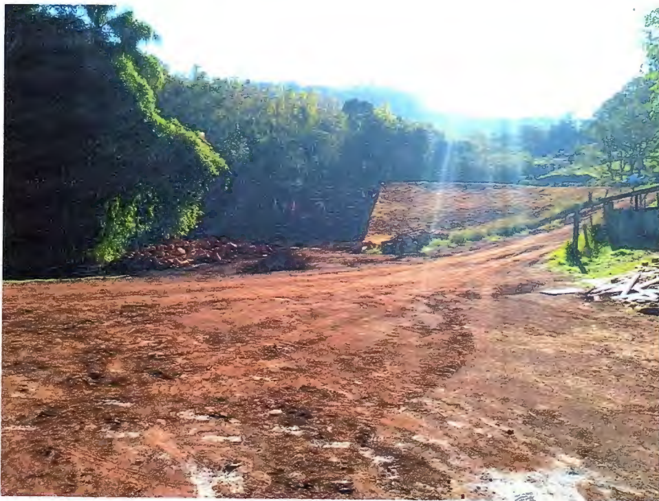
Foto 08 - Dia 06/04/2020, escavações vertedouro intermediário
