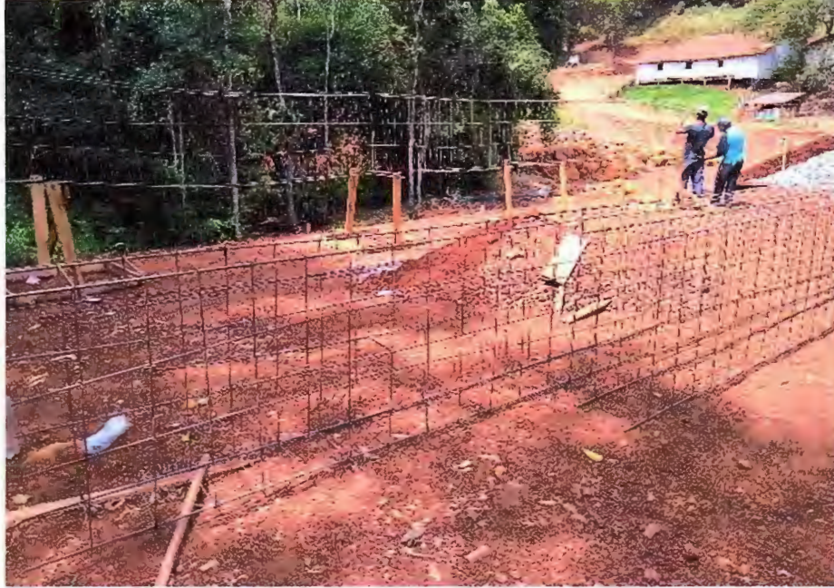
Foto 01 – Dia 04/03/2020, armação do vertedouro extravasor
