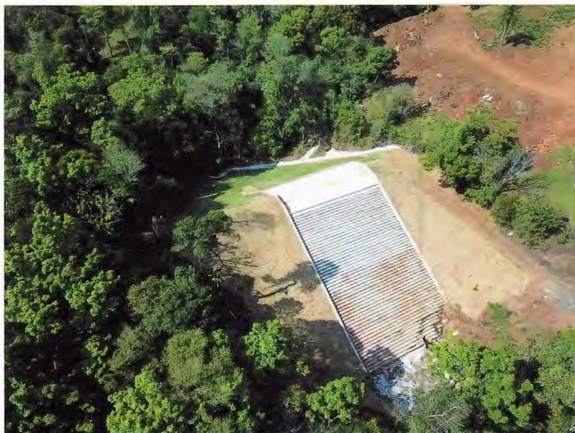
Foto 30 – Dia 22/09/2020, Aérea Barragem Concluída
