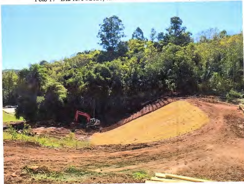
Foto 18 – Dia 15/04/2020, enleivamento do barramento à jusante
