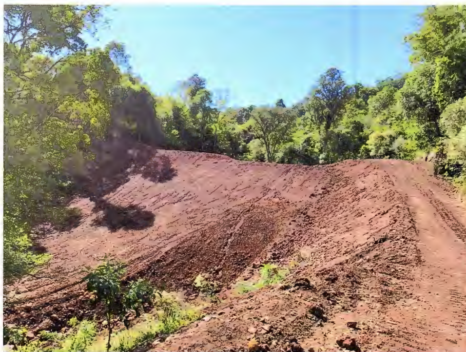
Foto 14 – Dia 15/04/2020, barramento à montante
