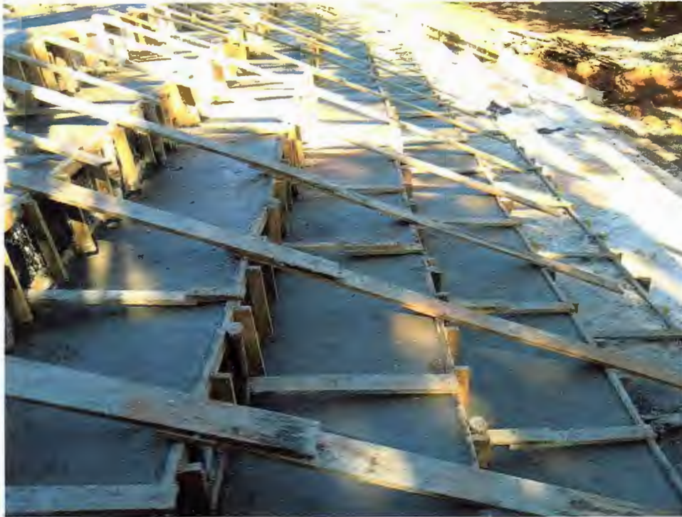
Foto 09 – Dia 10/04/2020, concretagem vertedouro
