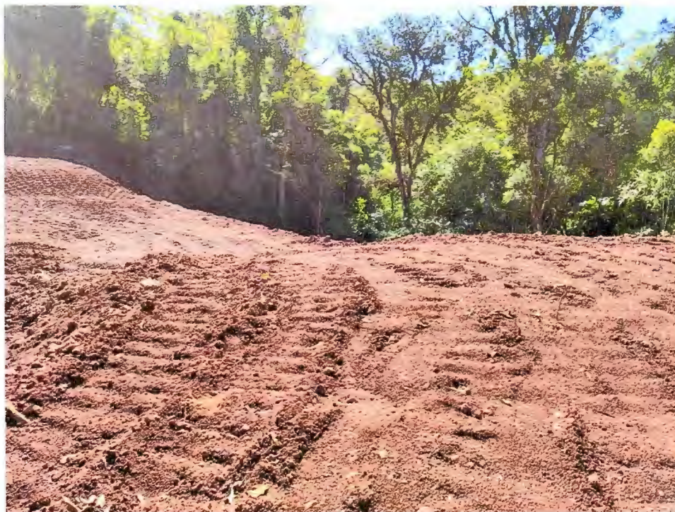
Foto 15 – Dia 15/04/2020, barramento à montante
