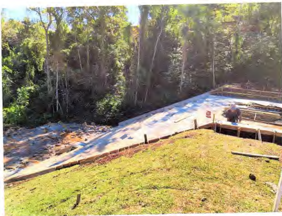
Foto 24 – Dia 15/04/2020, barramento intermediário
