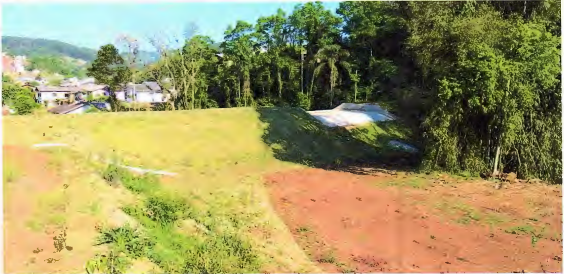
Foto 36 – Dia 22/09/2020, Barragem Concluída
