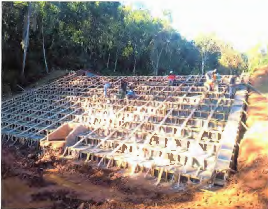
Foto 02 – Dia 19/03/2020, formas vertedouro extravasor
