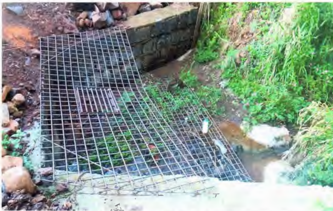
Figura 2 – META 01 - Reservatório para retenção de Água da Rua Marechal Deodoro – Concluído
