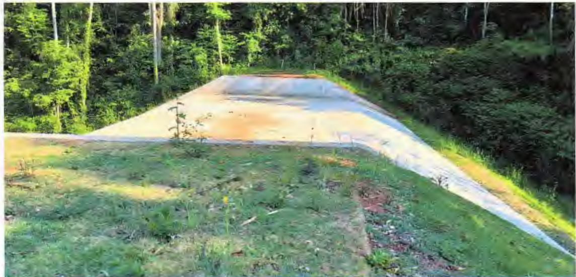
Foto 38 – Dia 22/09/2020, Barragem Concluída
