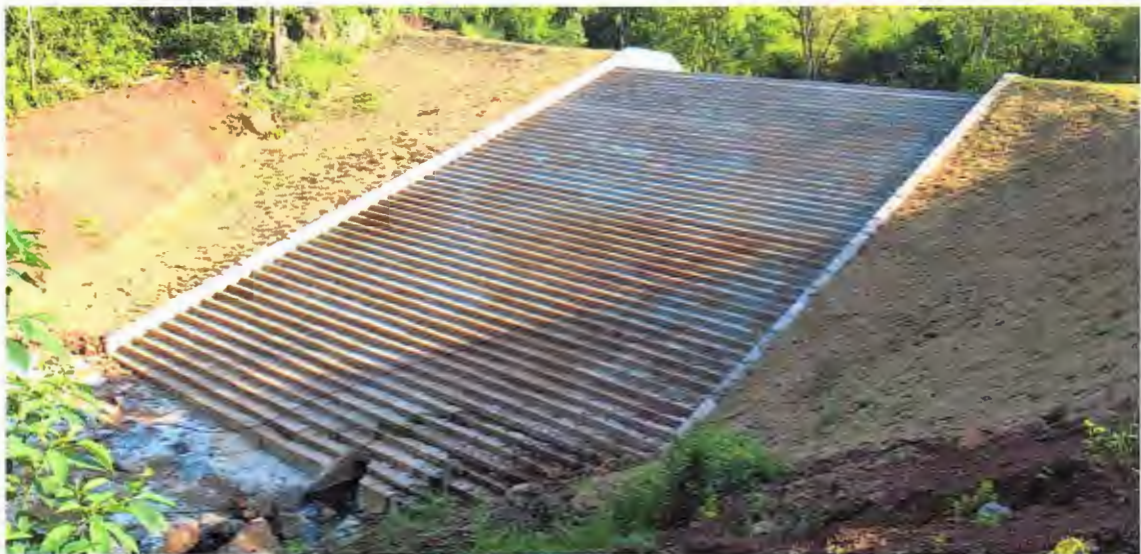
Foto 34 – Dia 22/09/2020, Barragem Concluída
