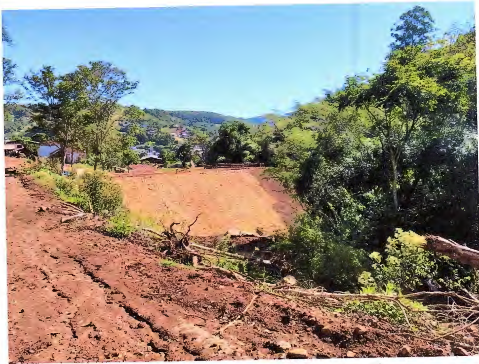
Foto 17 – Dia 15/04/2020, enleivamento do barramento à jusante
