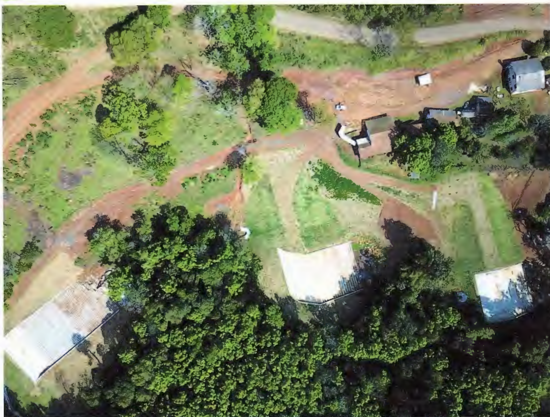
Foto 29 – Dia 22/09/2020, Aérea Barragem Concluída
