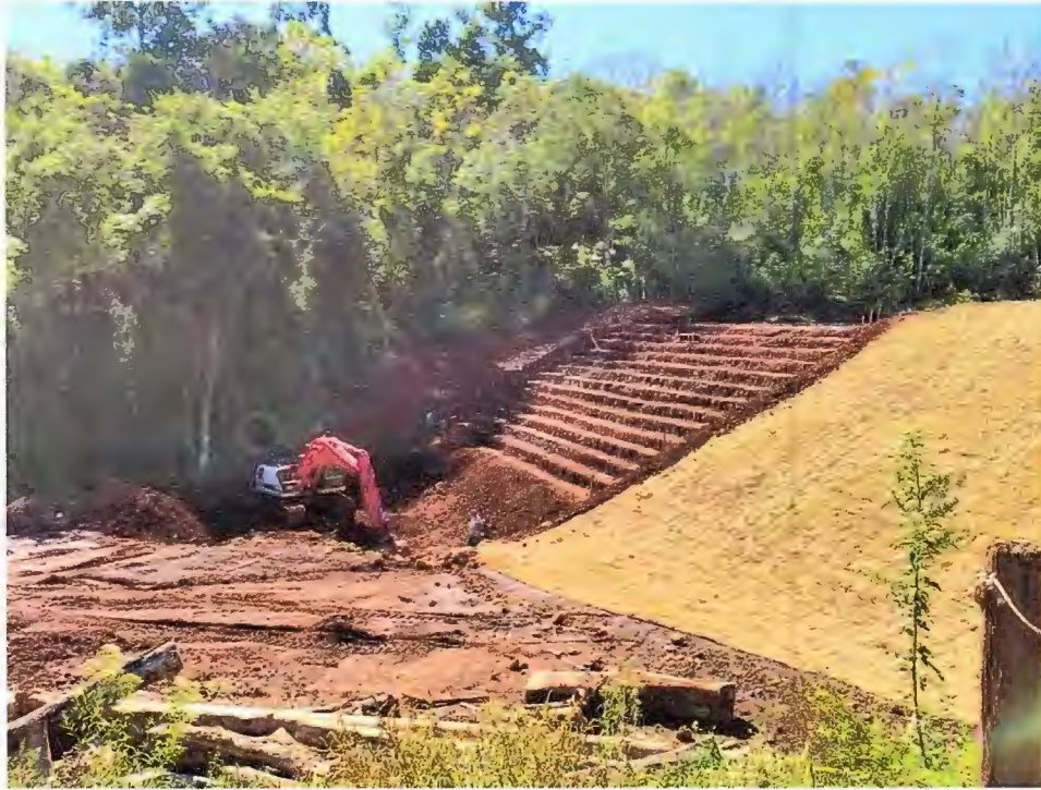
Foto 19 – Dia 15/04/2020, enlevamento do barramento à jusante
