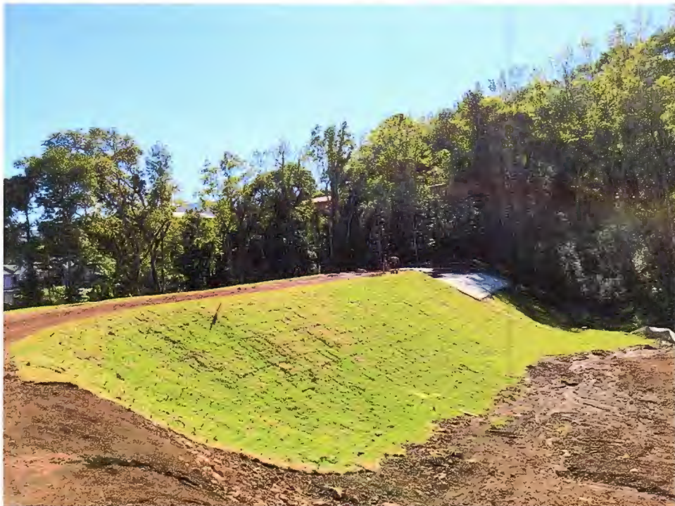
Foto 22 – Dia 15/04/2020, barramento à montante
