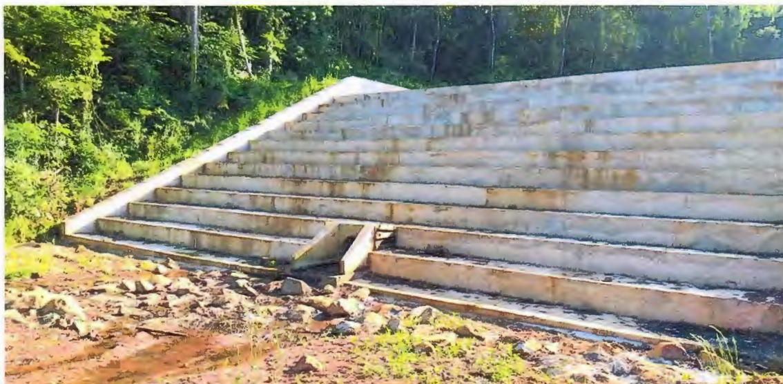
Foto 39 – Dia 22/09/2020, Barragem Concluída
