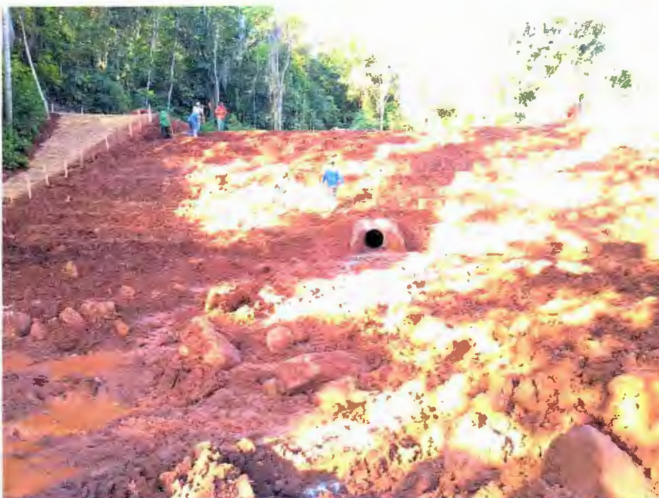
Foto 04 – Dia 05/03/2020, escavações para extravasor à jusante
