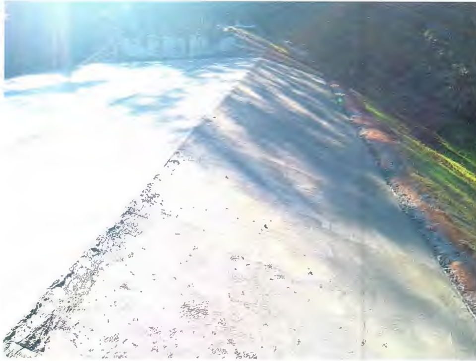
Foto 07 – Dia 10/04/2020, vertedouro jusante concretado
