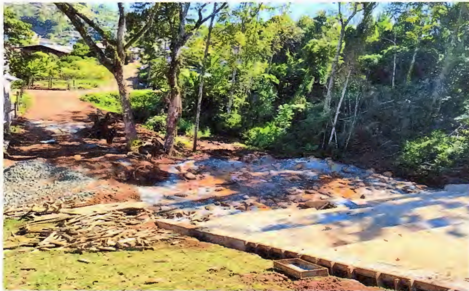
Foto 28 – Dia 15/04/2020, barramento intermediário
