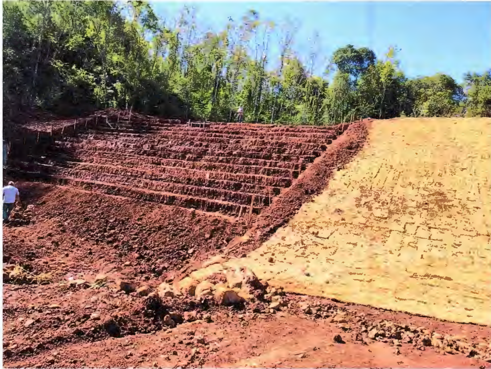
Foto 21 – Dia 15/04/2020, barramento à montante
