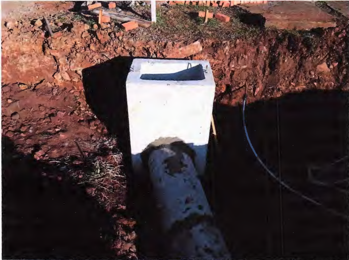
Figura 04 – META 02 - Execução do sistema de drenagem na Rua Marechal Deodoro
