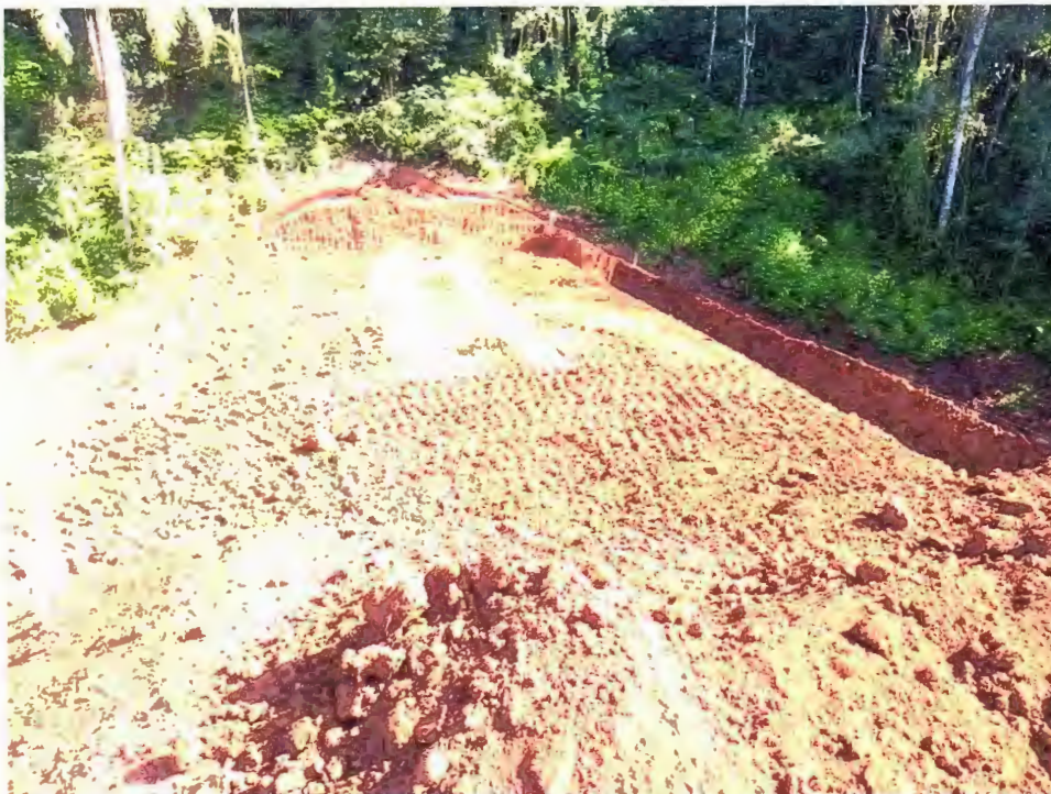
Foto 03 – Dia 05/03/2020, escavações para extravasor à jusante
