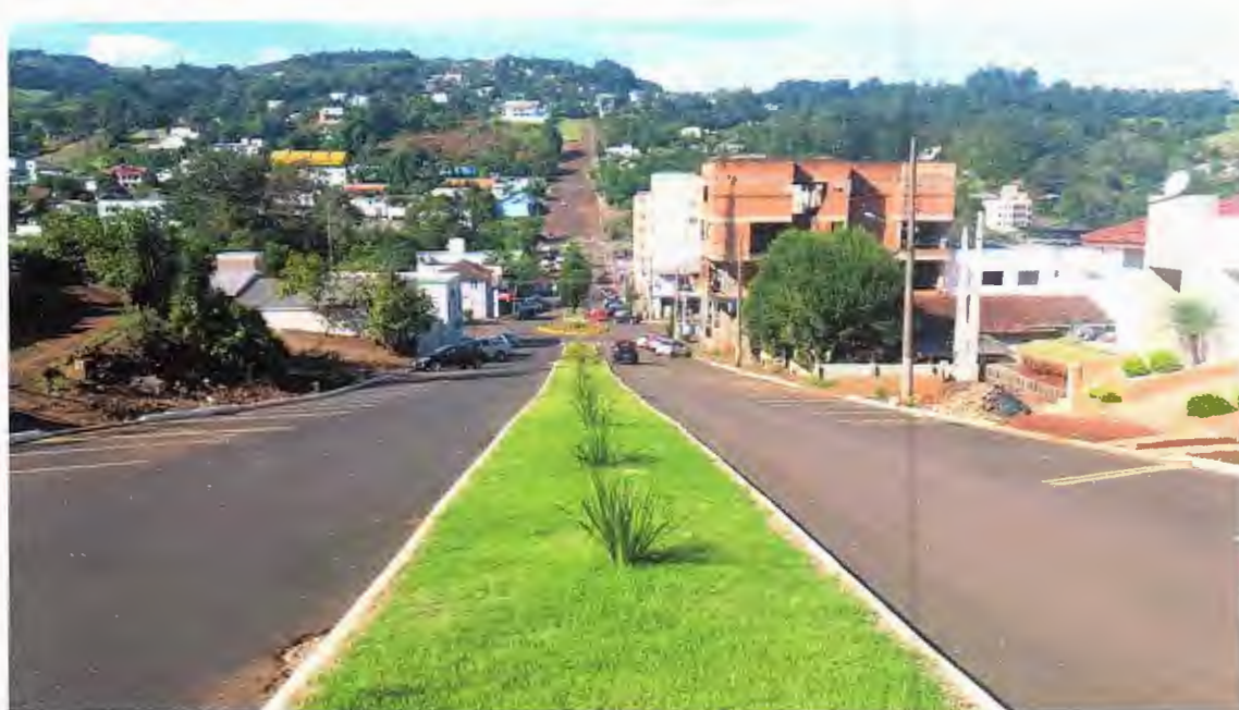
Figura 14 – META 03 – Pavimentação da Rua Marechal Deodoro - Concluída
