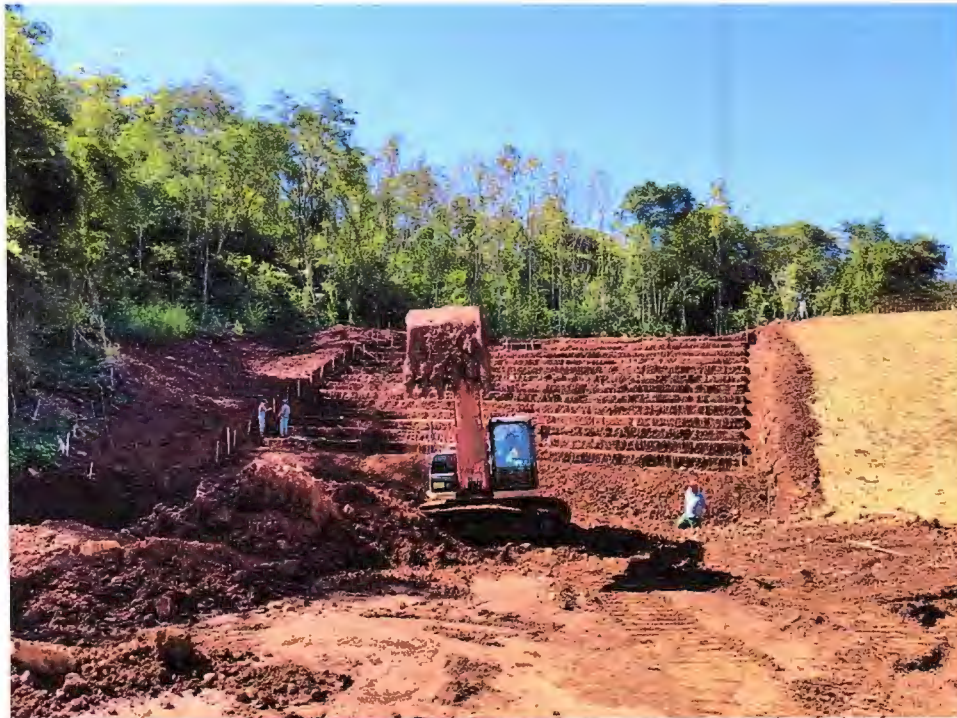
Foto 20 – Dia 15/04/2020, enlevamento do barramento à jusante
