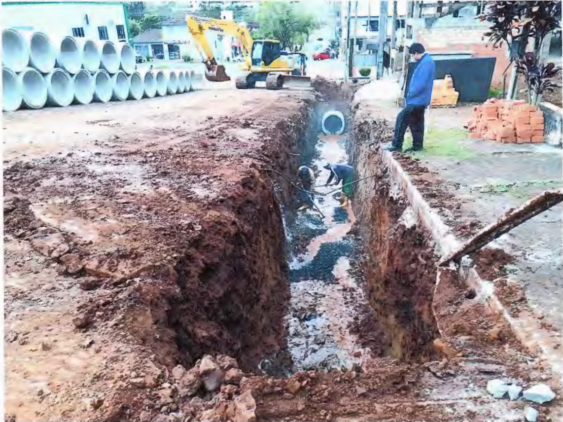
Figura 03 – META 02 - Execução do sistema de drenagem na Rua Marechal Deodoro
