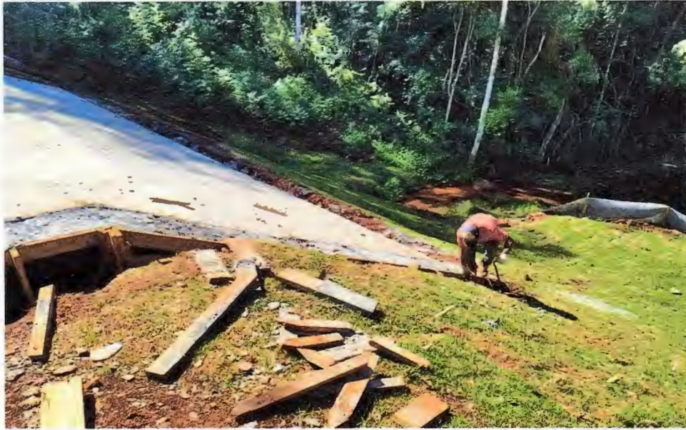
Foto 27 – Dia 15/04/2020, barramento intermediário
