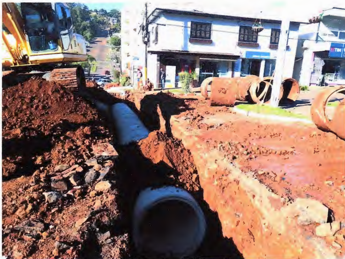
Figura 06 – META 02 - Execução do sistema de drenagem na Rua Marechal Deodoro
