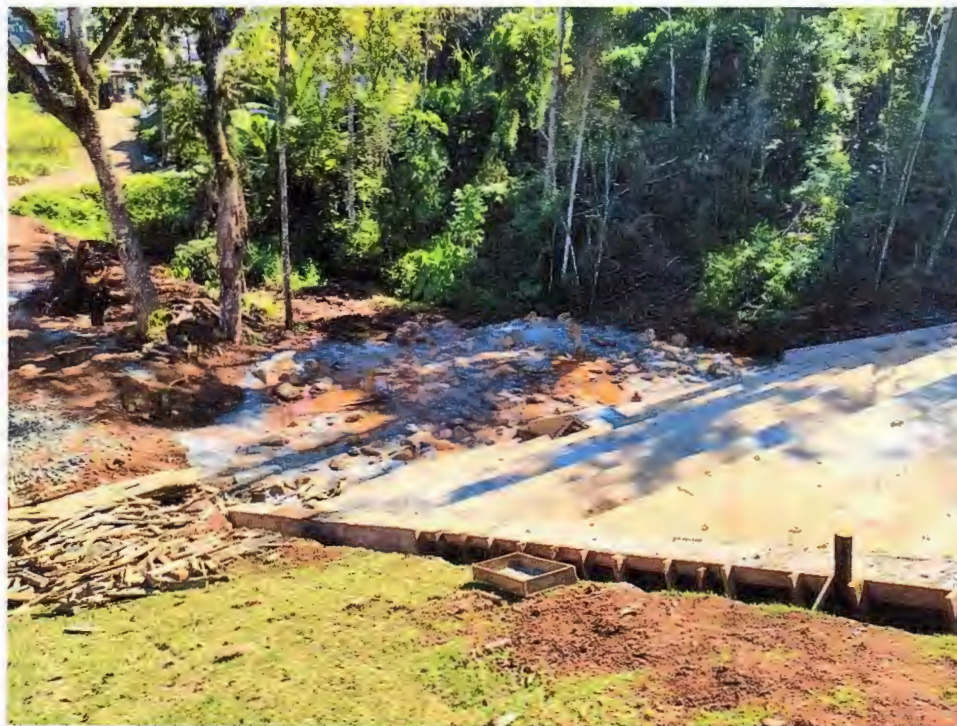
Foto 25 – Dia 15/04/2020, barramento intermediário
