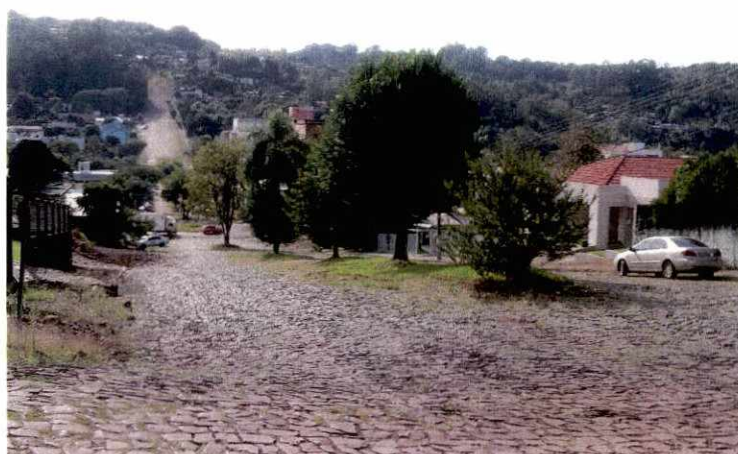
Imagem 3 - Trecho da Rua Marechal Deodoro a ser executado novo sistema de drenagem pluvial. Coordenadas Lat: 26°43'46.24"S e Lon: 52°43'14.34"O
