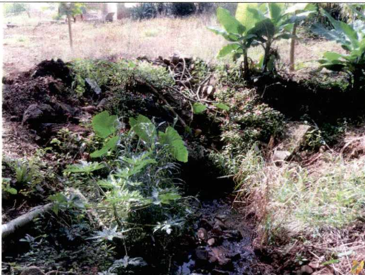
Imagem 4 - Local a ser executado o reservatório de retenção de água pluvial na fonte. Coordenadas Lat: 26°43'46.86"S e Lon: 52°43'17.00"O
