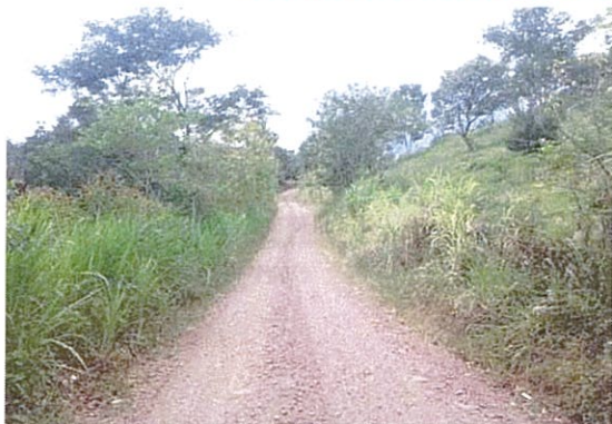
Figura 32 – Trecho em aclive com pista estreita
