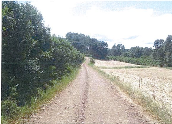
Figura 26 – Estreitamento de pista
