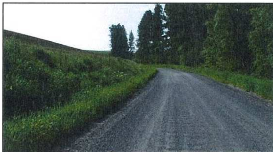
Figura 4 – Exemplo de talude protegido
