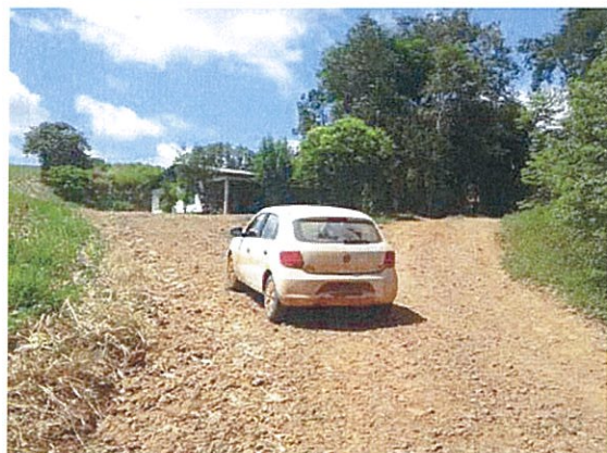
Figura 28 – Fim do Alinhamento 4
