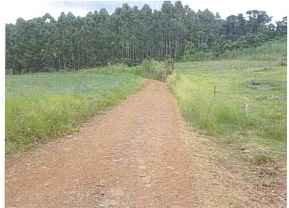
Figura 31 – Estreitamento de pista
