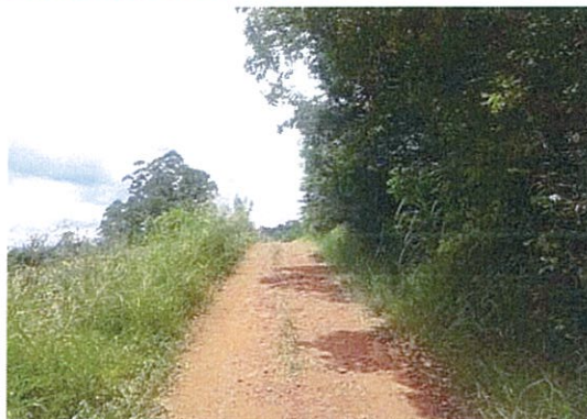
Figura 33 – Trecho em aclive com pista estreita
