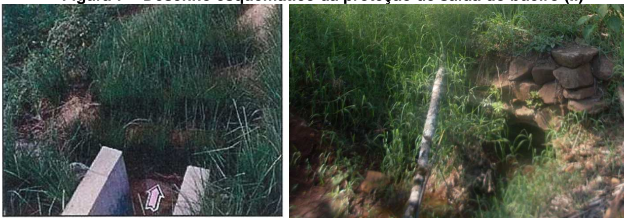
Figura 8 – Saída de bueiro protegida com vegetação
