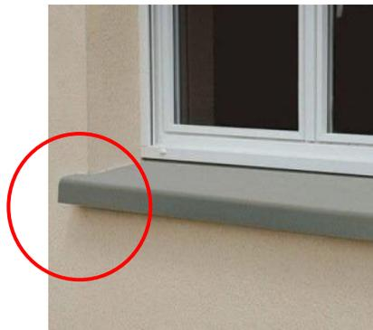
Figura 5- Peitoril embutido 1 cm na alvenaria
