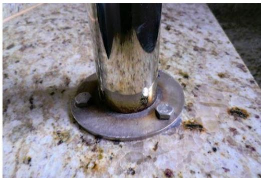
Figura 7- Fixação do Guarda-corpo
