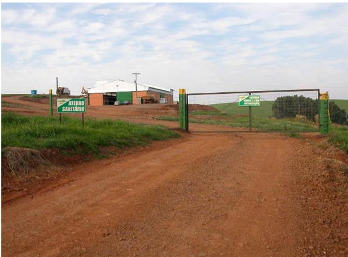
Foto 02 - Área Coberta para Recebimento dos Resíduos.
